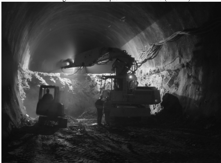
Figura 10: Escavação em andamento (NATM)
