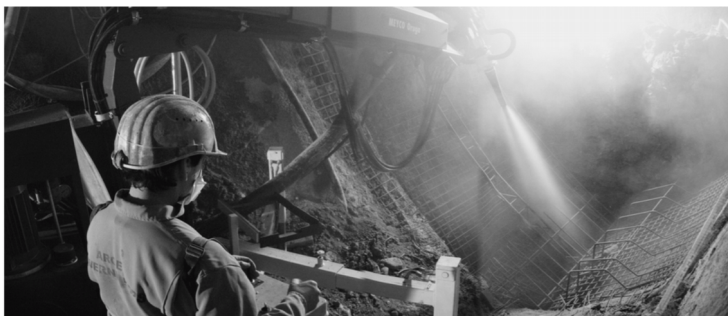
Figura 5: Execução do suporte de um túnel com concreto jateado
