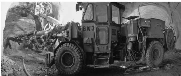
Figura 2: Instalação dos explosivos com o uso de maquinário
