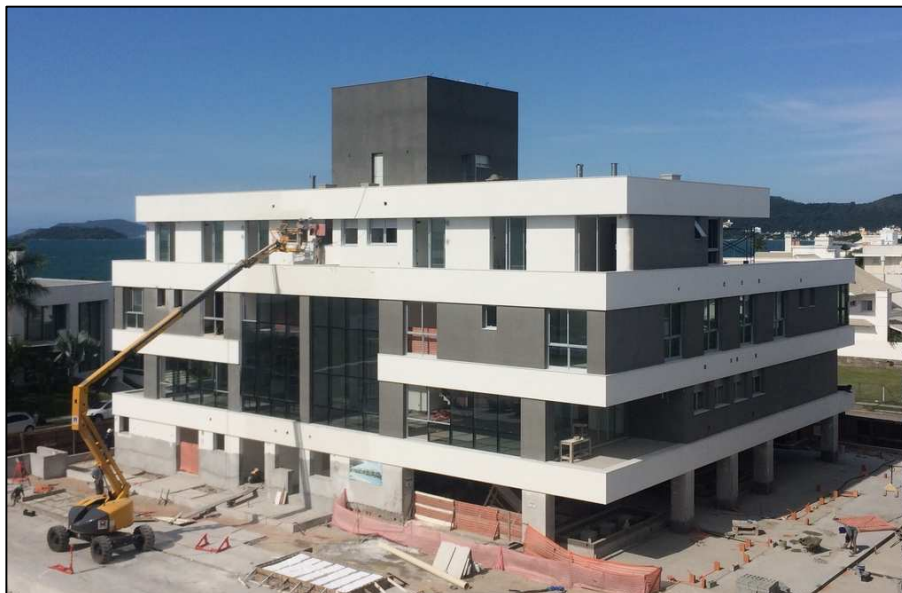
Figura 41 - Utilização de PTA para aplicação de textura
