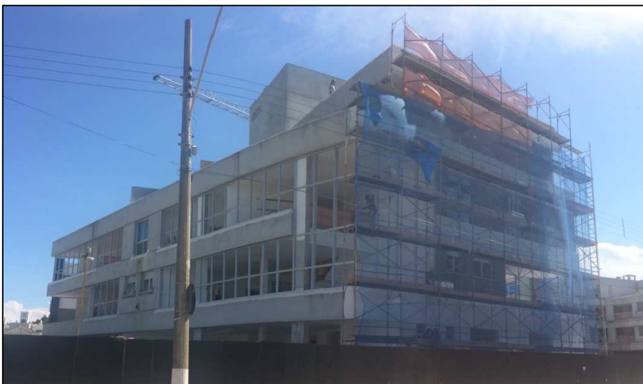
Figura 42 - Utilização de andaime fachadeiro para aplicação de textura
