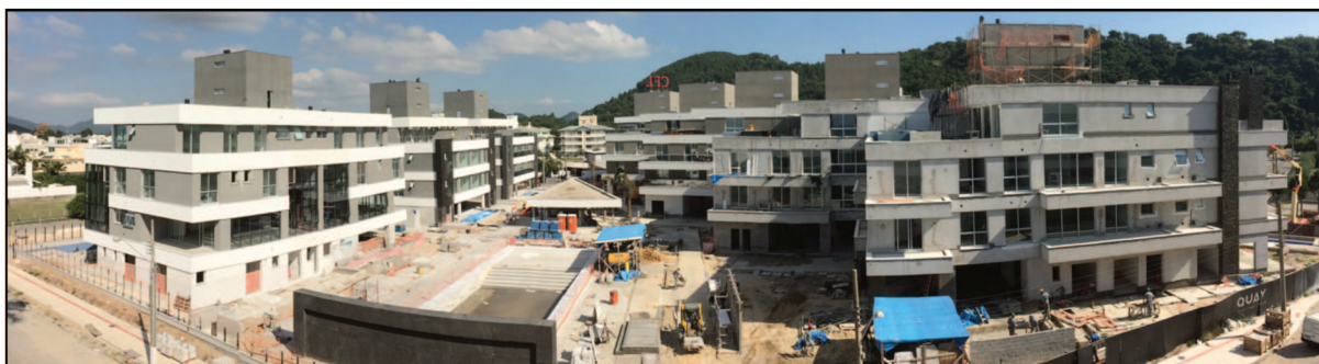
Figura 50 - Foto panorâmica da obra no final do estudo
