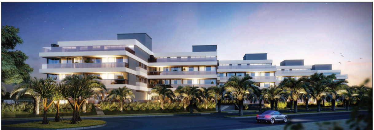
Figura 23 - Fachada Frente da Torre 1 (A, B, C, D e E) do empreendimento em estudo
