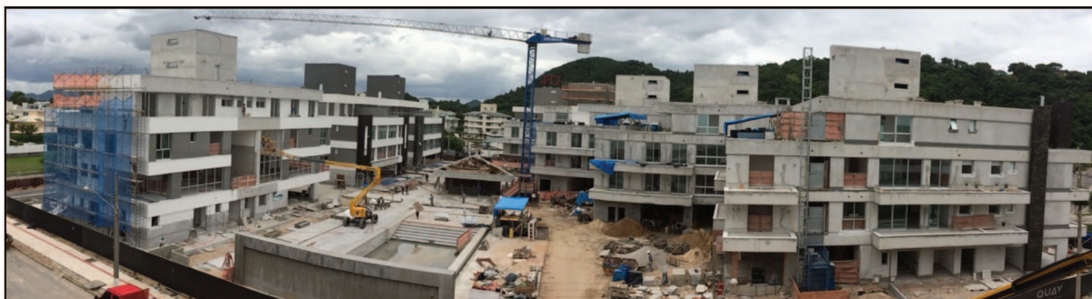
Figura 49 - Foto panorâmica da obra no início do estudo
