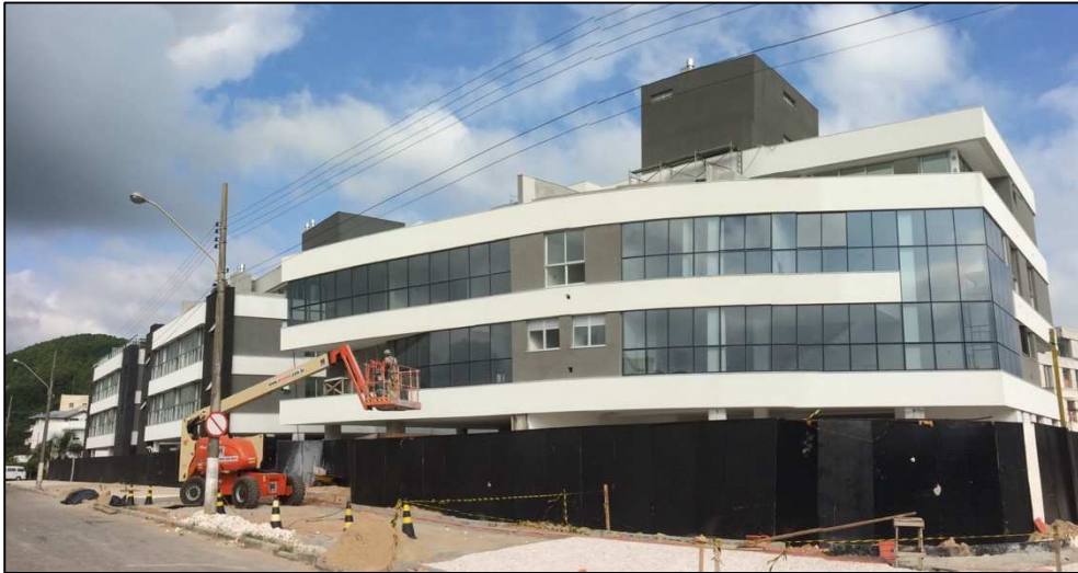
Figura 44 - Foto da fachada com pele de vidro da torre 4
