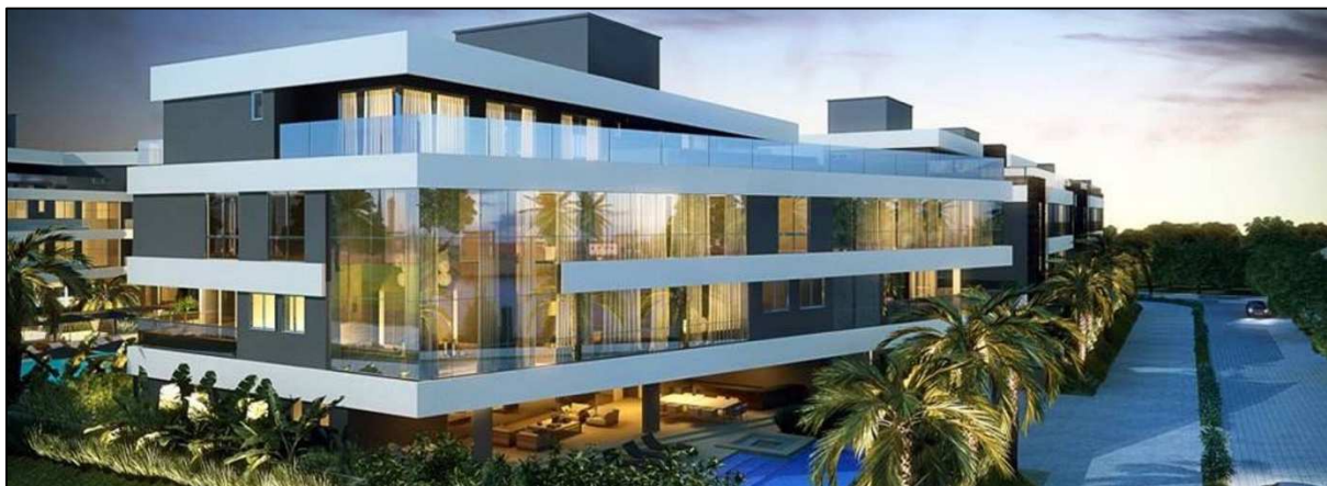
Figura 25 – Fachada Frente da Torre 4 do empreendimento em estudo
