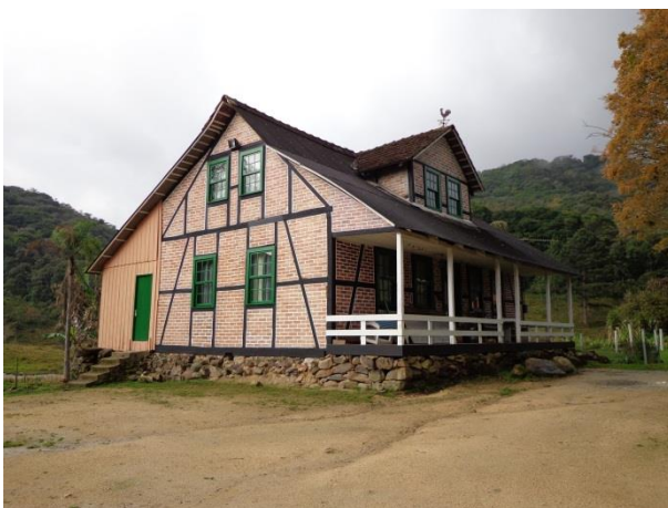
Figura 4: Edifício escolar utilizado como dormitório parcialmente restaurado. Foto tirada em 03 de setembro de 2013.
