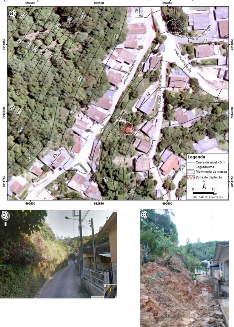
Figura 4.15 – a) Localização do deslizamento deflagrado nos elevados índices pluviométricos de janeiro de 2015, possivelmente associado ao talude de corte. b) Foto obtida no aplicativo Google Street View , demonstrando a rua e o talude antes da ocorrência do deslizamento. c) Registro fotográfico realizado no dia do evento (08 de janeiro).
