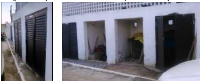
Figura 32. Depósito de materiais dos serviços de manutenção de rede.
