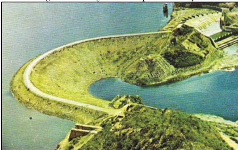
Figura 3.4 - Barragem de Orós após a reconstrução
