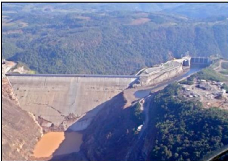
Figura 3.6 - Imagem aérea da UHE Campos Novos após o acidente.
