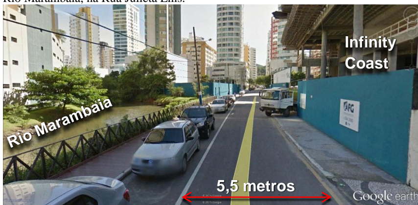
Figura 101 – Tapumes de construção do condomínio Infinity Coast, às margens do Rio Marambaia, na Rua Julieta Lins.
