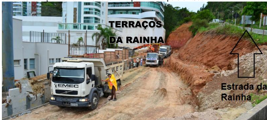
Figura 132 – Parte do desbarrancamento causado devido à construção do acesso ao edifício Terraços da Rainha e ao terreno permutado pelo ex-Secretário.
