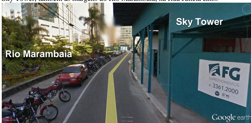
Figura 102 – Trinta metros mais à frente, tapumes de construção do condomínio Sky Tower, também às margens do Rio Marambaia, na Rua Julieta Lins.
