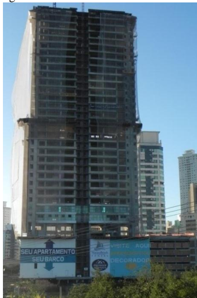
Figura 124 – Marina Beach Towers em construção, 2014.
