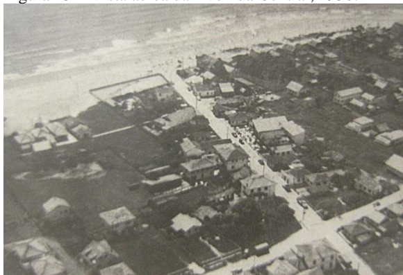
Vista aérea da Avenida Atlântica, esquina com Avenida Central - Década de 1950
