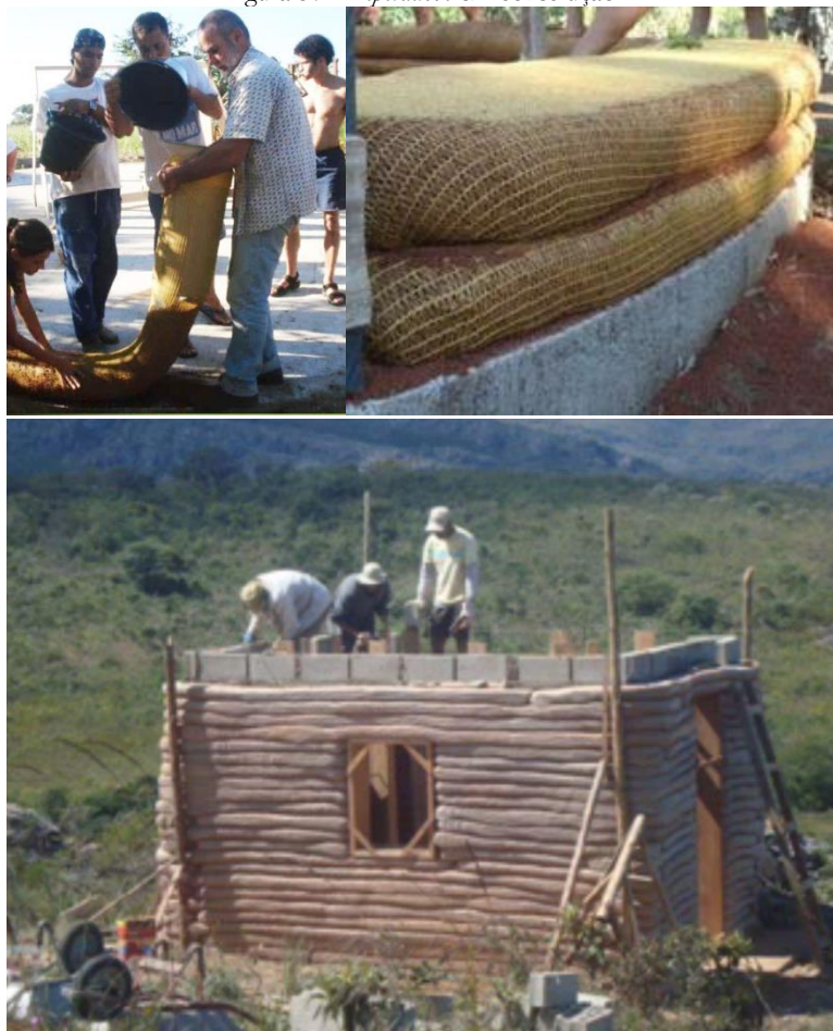
Figura 57 - Hiperadobe em construção.
