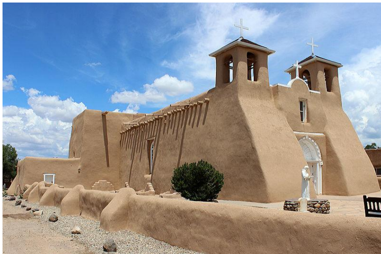
Figura 82 - Igreja de São Francisco, Rancho de Taos. Má experiência com reboco de cimento e volta ao reboco de barro.
