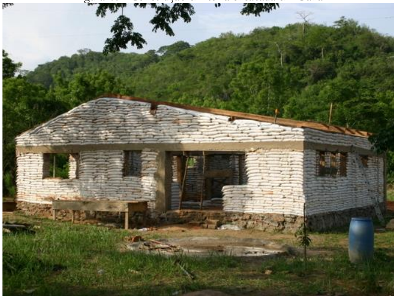
Figura 40 - Construção em terra ensacada em Gana.
