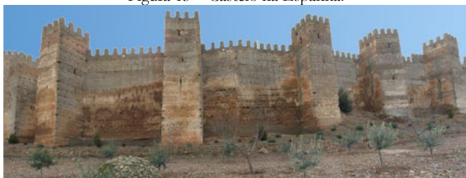
Figura 13 – Castelo na Espanha.
