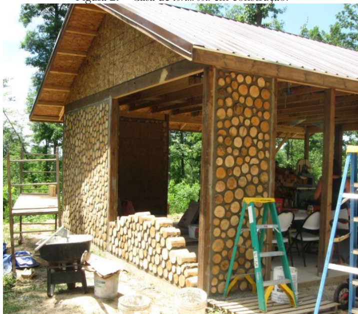
Figura 29 - Casa de cordwood em construção.
