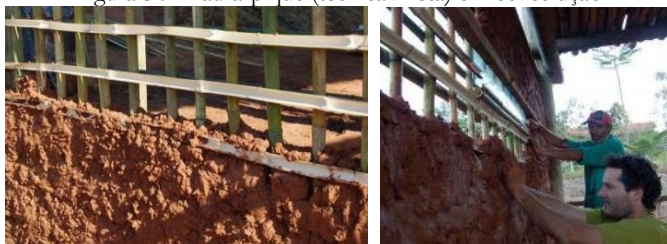
Figura 34 - Pau-a-pique (técnica mista) em construção.
