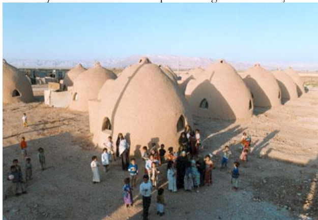
Figura 45 - Superadobe usado em campo de refugiados das Nações Unidas.
