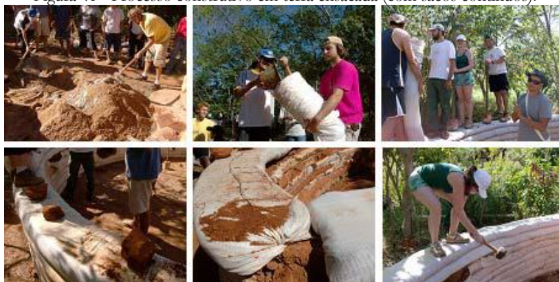
Figura 41 - Processo construtivo em terra ensacada (com sacos contínuos).
