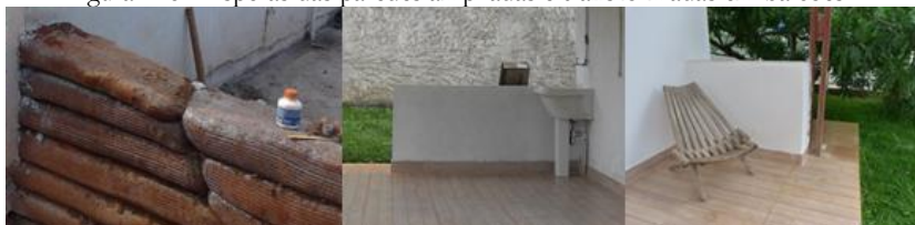
Figura 116 - Esperas das paredes ampliadas e transformadas em balcões.
