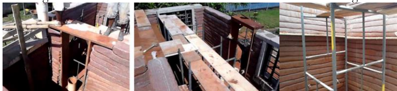
Figura 107 - Processo construtivo visto de cima do nível das vergas.
