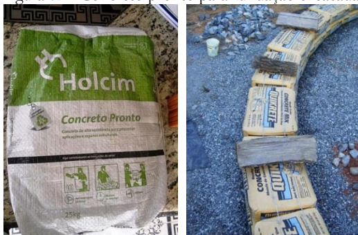
Figura 72 - Concreto pronto para fundação ensacada.
