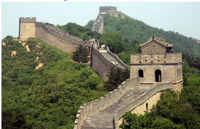
Figura 14 - Muralha da China.
