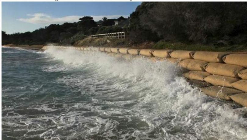
Figura 46 - Terra ensacada para controle de erosão.
