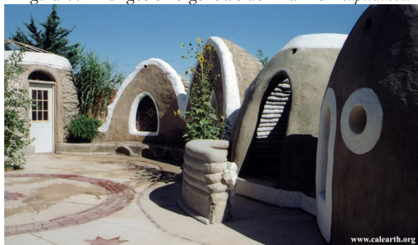
Figura 44 - Abrigos emergenciais de Khalili em superadobe .
