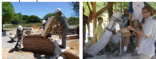
Figura 62 - Suporte para cano-funil da Biohabitate e de Owen Geiger.
