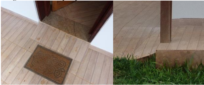
Figura 122 - Rampas para facilitar a acessibilidade.
