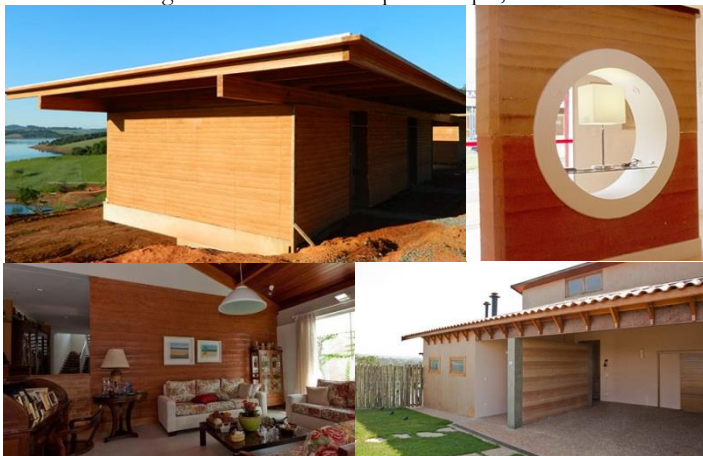
Figura 39 - Obras da empresa Taipal, Brasil.
