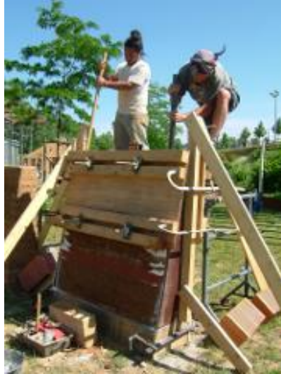
Figura 37 - Fabricação da taipa de pilão.
