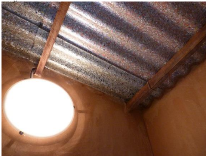
Figura 138 - Telhas de material reciclado refletindo a luz recebida.
