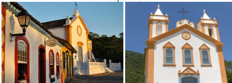
Figura 22 – Construções açorianas em terra e alvenaria de pedra em Florianópolis-SC.
