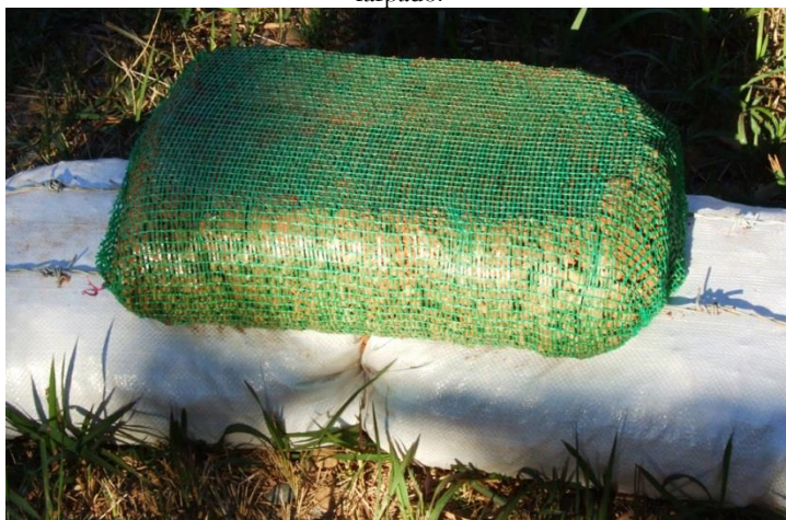
Figura 42 – Dois tipos de sacarias preenchidas, compactadas e ligadas por arame farpado.
