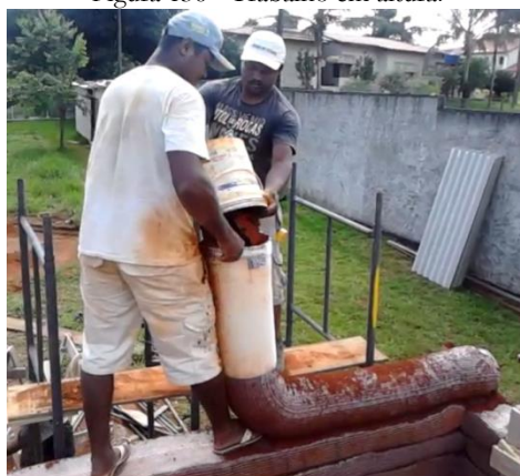
Figura 136 - Trabalho em altura.
