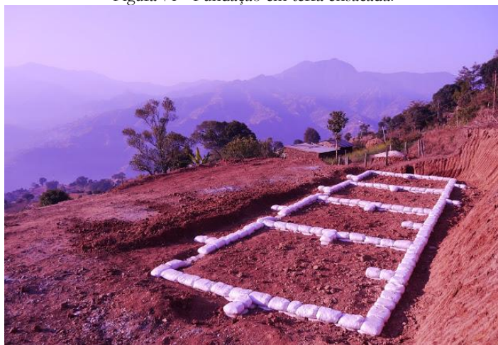
Figura 71 - Fundação em terra ensacada.
