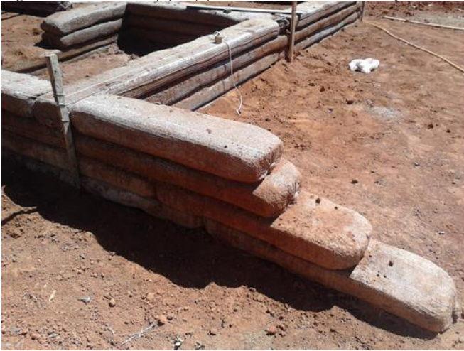
Figura 106- Módulos (A) e (B) - Detalhe da extensão da parede.
