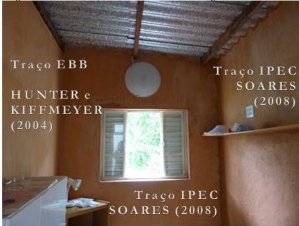
Figura 127 - Rebocos alternativos - vista geral e referências.
