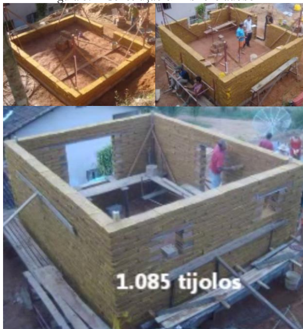
Figura 59 - Construção em "brickeradobe".
