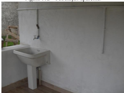
Figura 112 - Tubulação aparente.
