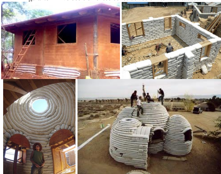
Figura 43 - Diversos elementos construtivos em terra ensacada.
