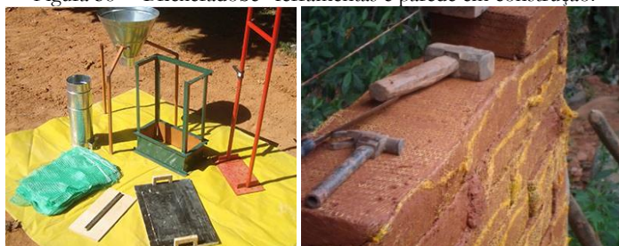
Figura 58 - "Brickeradobe" ferramentas e parede em construção.
