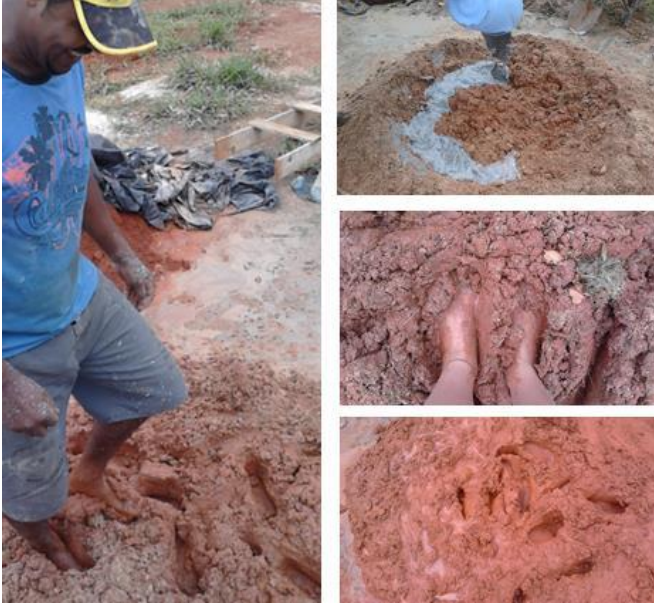
Figura 118 Reboco sendo misturado com os pés: antes, durante e depois.
