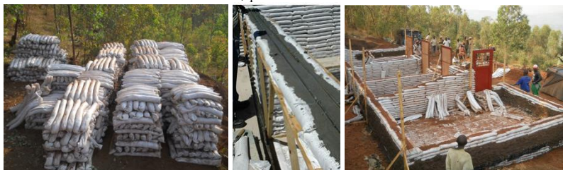
Figura 61 – Sacaria pré-preenchida; cinta de amarração enformada pela sacaria costurada; processo construtivo.
