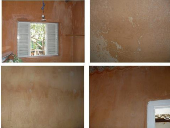
Figura 128 - Rebocos de terra com colorações desuniforme.
