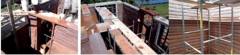
Figura 137 - Processo construtivo visto no nível das vergas.
