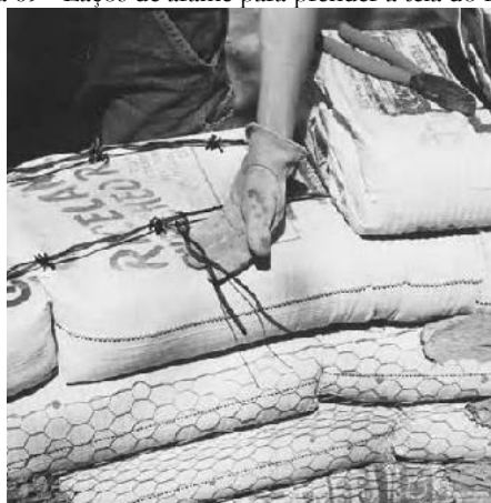
Figura 69 - Laços de arame para prender a tela do reboco.
