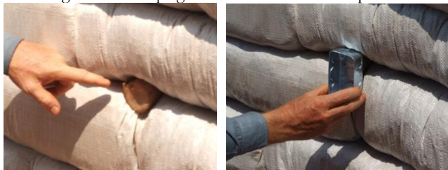
Figura 81 - Acoplagem da caixa de tomada à parede.
