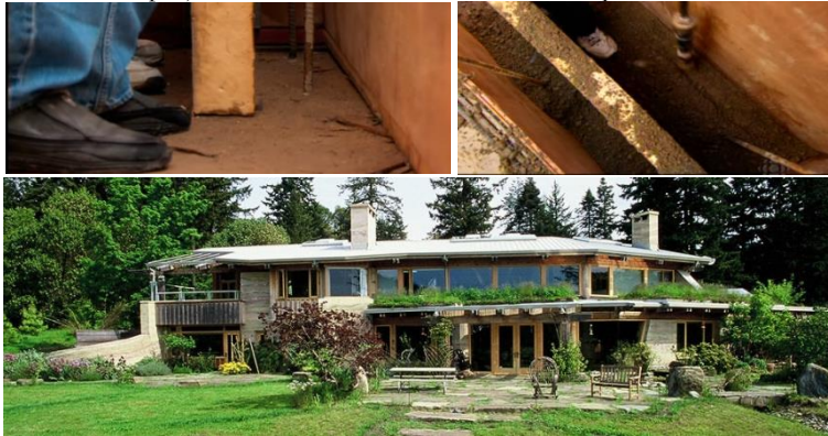
Figura 38 - Sistema SIREWALL de isolamento, reforço e compactação da taipa; projeto residencial realizado em terra compactada.
