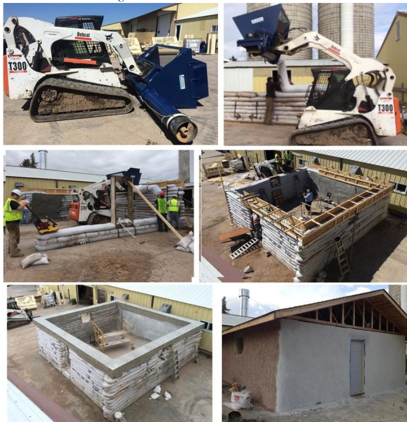
Figura 64 - Terra ensacada mecanizada.
