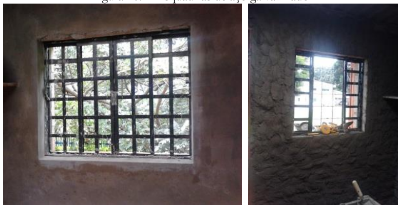
Figura 109 - Esquadrias de aço galvanizado.
