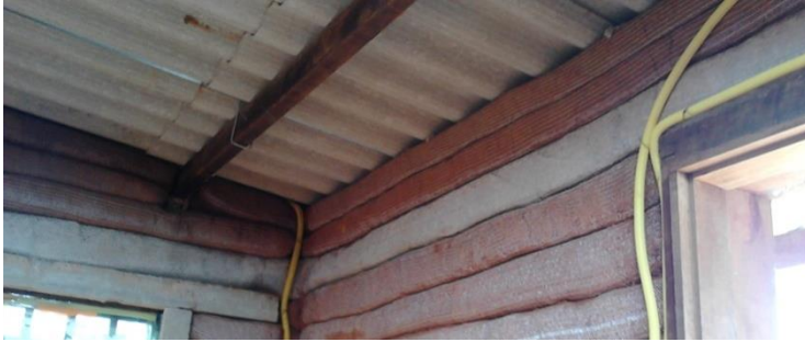
Figura 111 Cinta de amarração em terra ensacada estabilizada.
