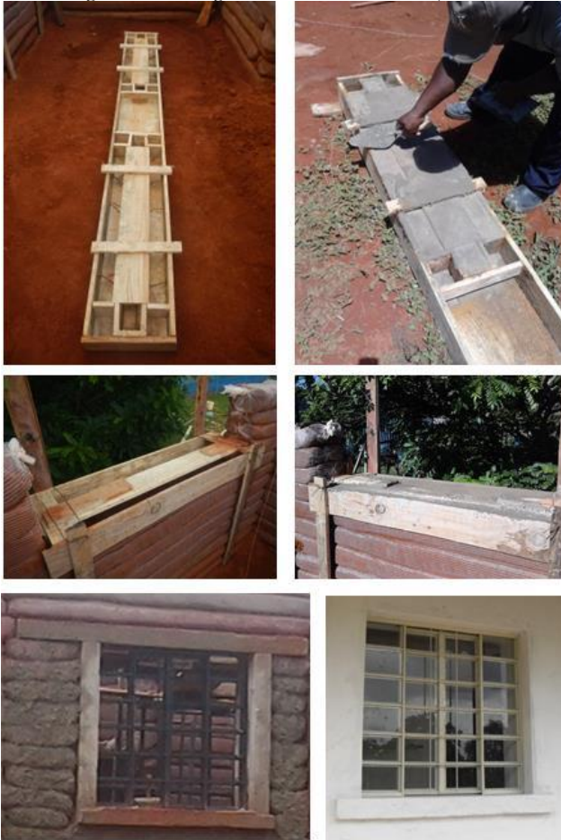
Figura 108 - Vergas em concreto leve das janelas.
