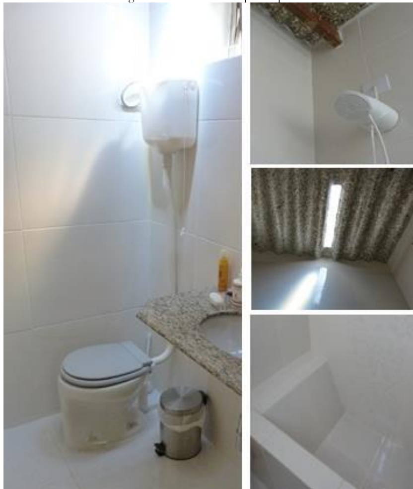
Figura 129 - Banheiro do protótipo.
