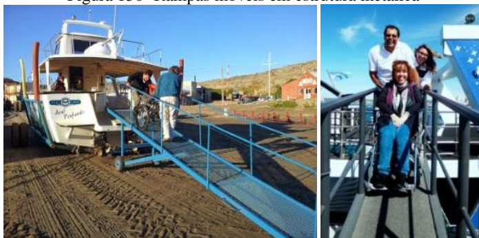
Figura 150- Rampas móveis em estrutura metálica
