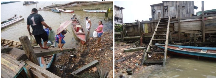
Figura 188. Escada que dar acesso à área de embarque/ desembarque sem nenhuma segurança, onde uma idosa precisa se apoiar nos degraus para conseguir descer
