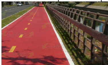
Figura 105- Guarda corpo de madeira plástica
