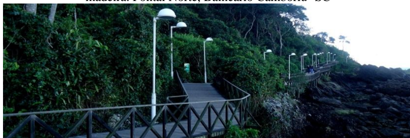
Figura 111- Exemplo de iluminação pública bem distribuída em calçadas de madeira. Pontal Norte, Balneário Camboriú- SC
