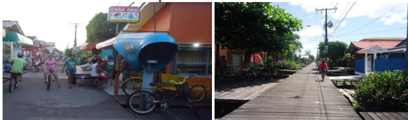
Figura 78- Calçadas em concreto e de madeira sem delimitação do espaço para pedestre e ciclistas
