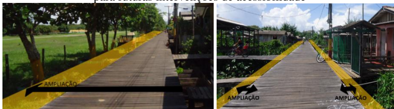
Figura 134- Calçadas- tipo a e b, respectivamente, utilizadas como exemplos para futuras intervenções de acessibilidade
