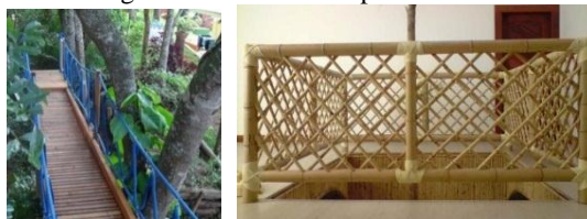
Figura 104- Guarda corpo de bambu
