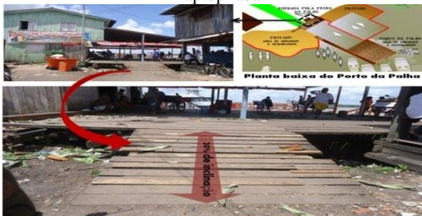
Figura 181. Porto da Palha e o acesso feito por uma rampa de madeira inapropriada
