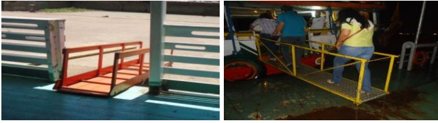
Figura 29. Rampa estreita utilizada para o acesso ao barco
