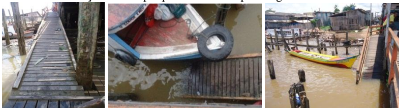
Figura 186. Rampa de madeira para o acesso ao embarque e desembarque. Situação da rampa quando coberta pelas águas da maré
