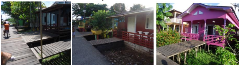
Figura 84- Calçadas de acesso às casas de madeira
