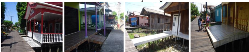
Figura 83- Calçadas de acesso às casas com pisos escorregadios, desníveis acentuados e inclinação íngreme
