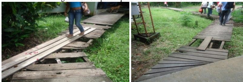
Figura 70- Calçadas que dá acesso ao Posto de Saúde
