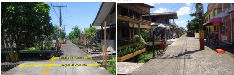
Figura 57- Transição calçada de madeira para concreto. Observa-se nas figuras a posição do poste de iluminação na calçada de madeira e na construída de concreto
