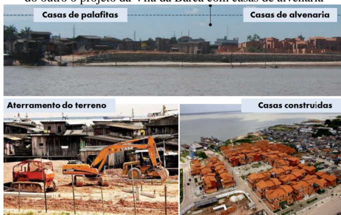
Figura 3- Fotos que mostram a contradição: de um lado as casas de palafitas e do outro o projeto da Vila da Barca com casas de alvenaria
