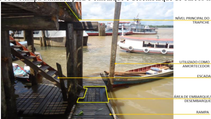
Figura 184. Rampa utilizada para o embarque e desembarque de barcos maiores
