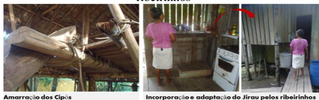
Figura 16- Utilização do cipó para amarrações e a adaptação do jirau pelos ribeirinhos
