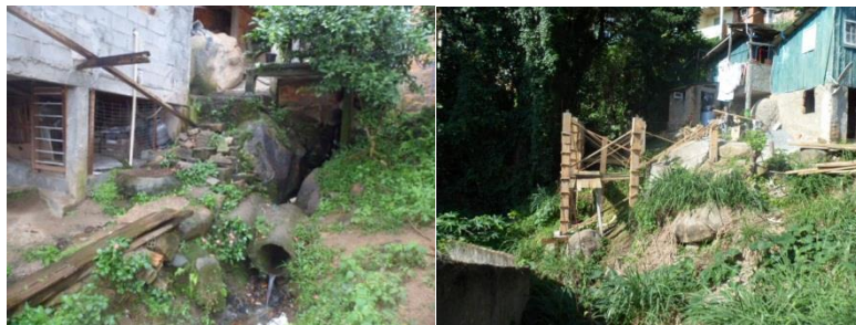
Figura 14 – Ocupação sobre linha de drenagem.
