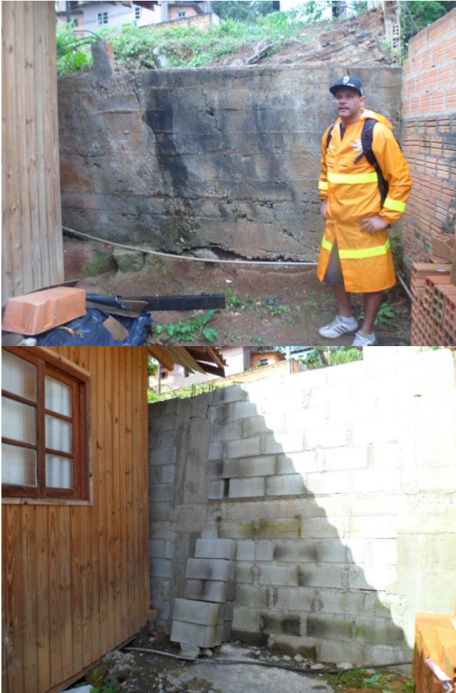
Figura 48 – Restruturação de contenção.
