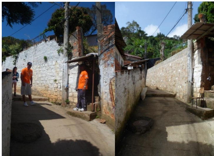
Figura 49 – Restruturação de contenção.
