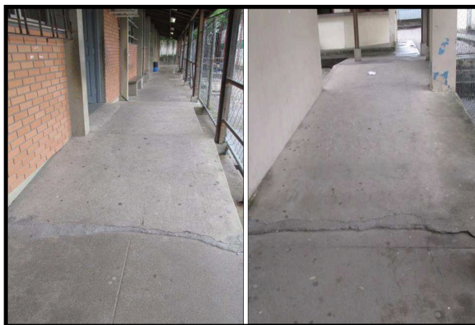
Figura 10 – Foto desníveis na rota acessível
