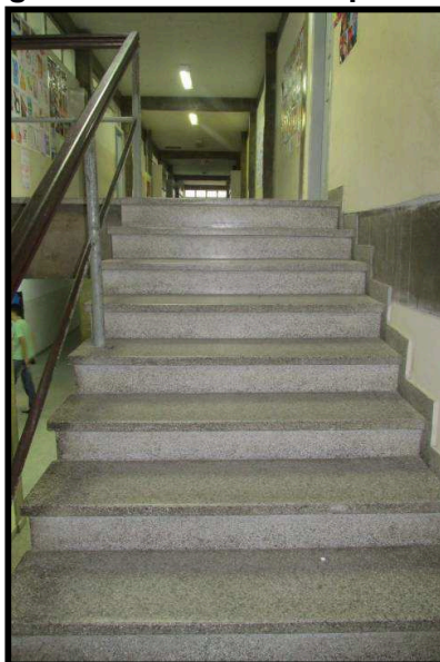
Figura 8 – Foto escada prédio 2
