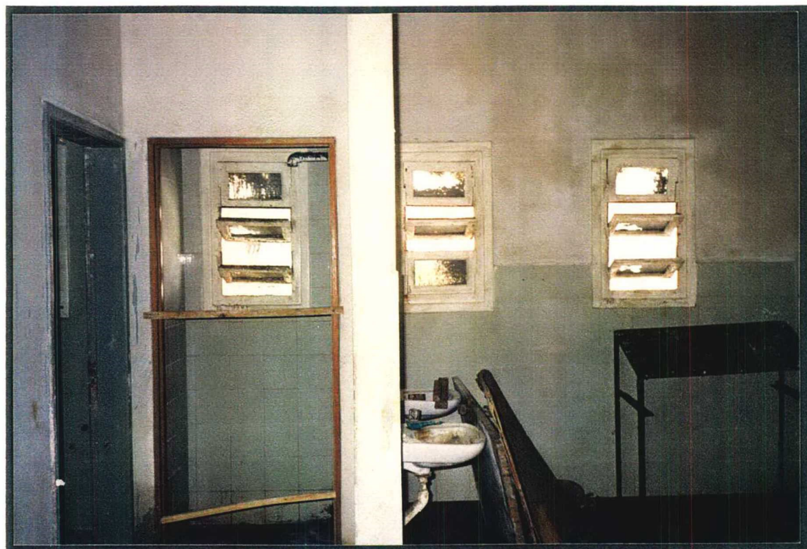
Figura 39 — Fotografia da área de manutenção de turno no NPK (01/95)
