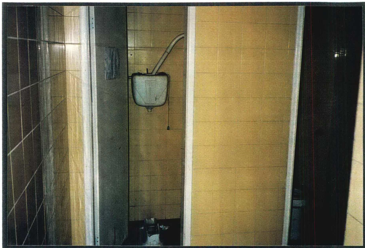
Figura 35 — Fotografia do banheiro da ensacadeira (01/95)
