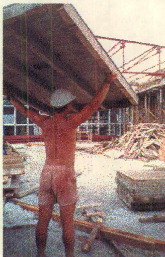
Figura 16: Situação real na atividade de carregamento de painéis.
