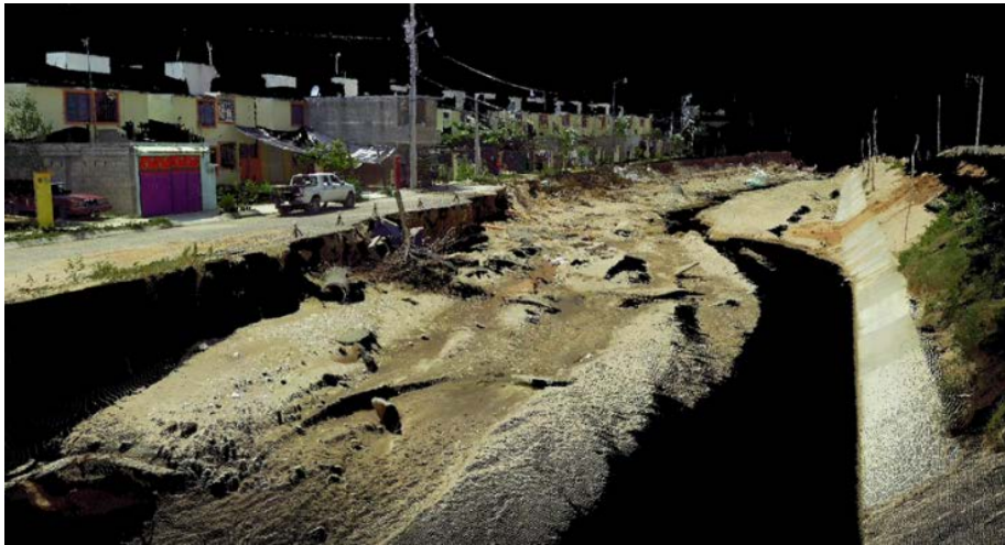
Figura 15 - Levantamento da área do desastre com Laser Scanner.
