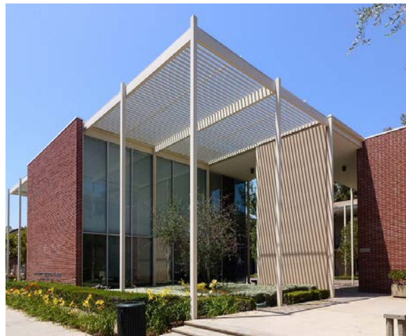
Figura 55 - Vista da Fachada do URC.
