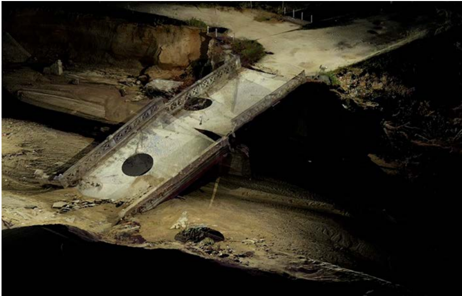
Figura 13 - Levantamento da área do desastre com Laser Scanner.
