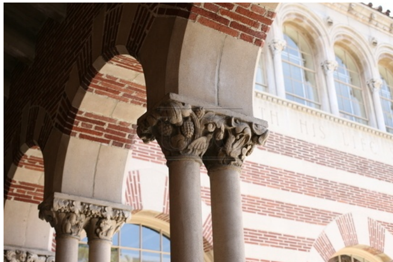
Figura 23 - Detalhes dos adornos esculturais existentes na edificação.
