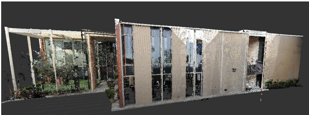
Figura 58 - Nuvem de pontos da fachada leste do URC.
