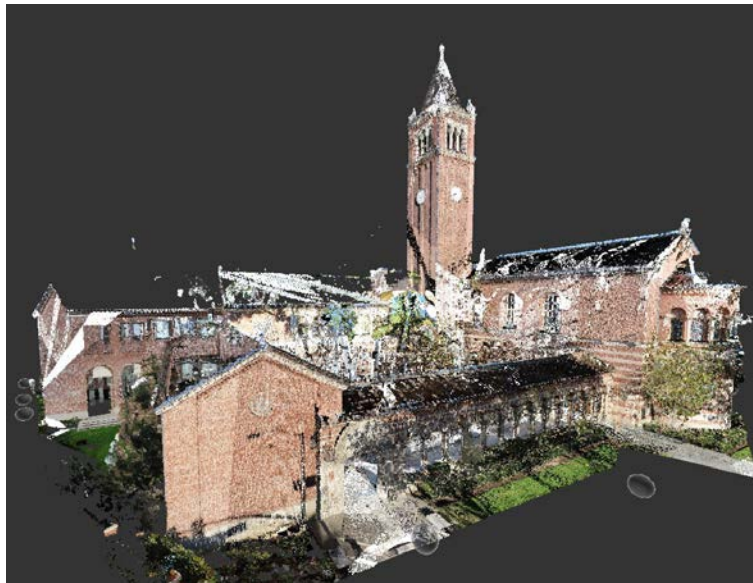
Figura 46- Nuvem de pontos da fachada leste do Mudd Hall.
