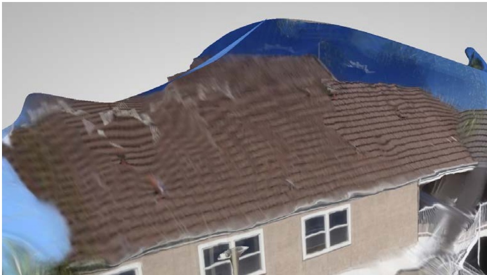
Figura 77 - Deformações encontradas em pontos no telhado da edificação.
