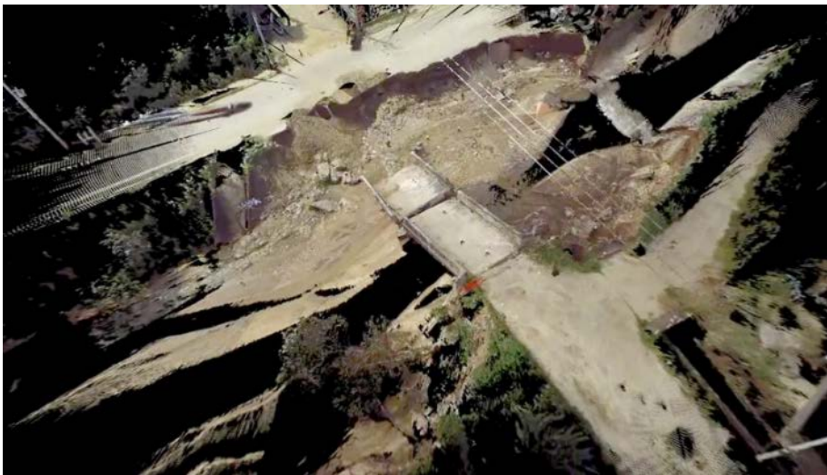
Figura 14 - Levantamento da área do desastre com Laser Scanner.
