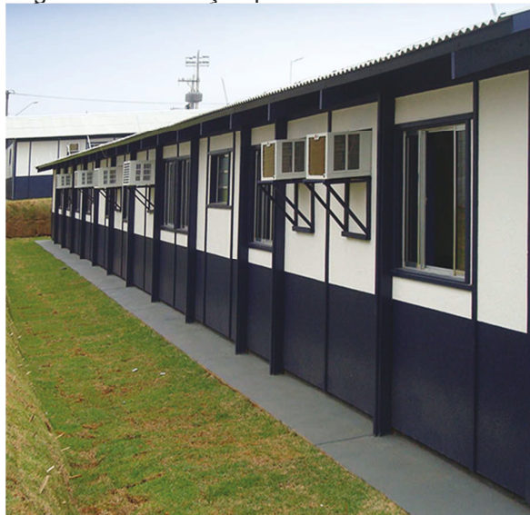
Figura 3 - Construção pré-Fabricada de madeira
