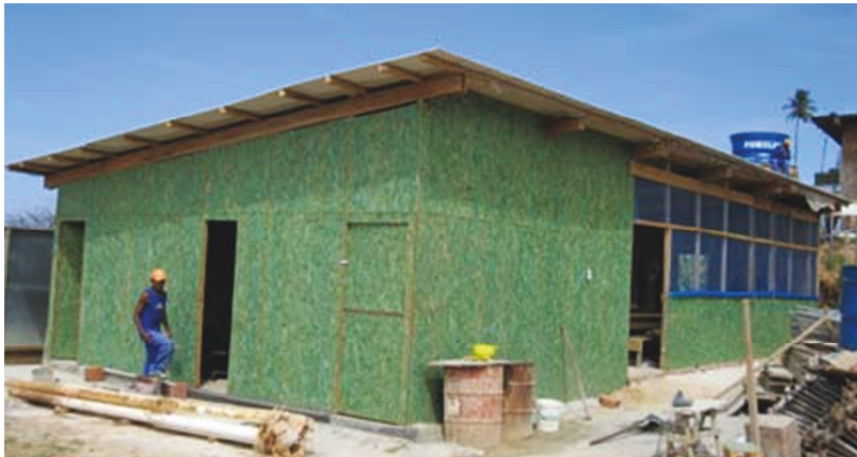
Figura 2 - Sistema tradicional em chapas de madeira compensada
