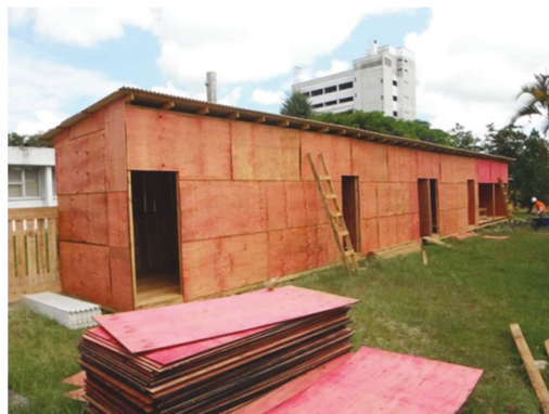
Figura 14 - Instalação de canteiro executada com chapas de madeira compensada
