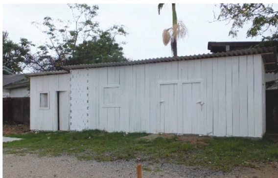
Figura 15 - Instalação de canteiro executada com tábuas de madeira
