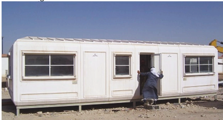
Figura 7 - Escritório de obra em fibra de vidro
