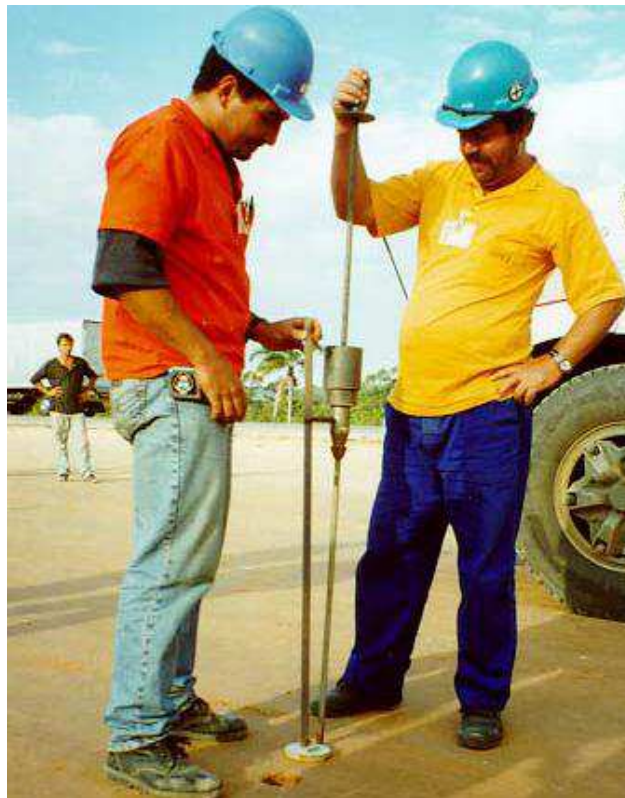
Figura 1 - Execução do ensaio DCP em campo
