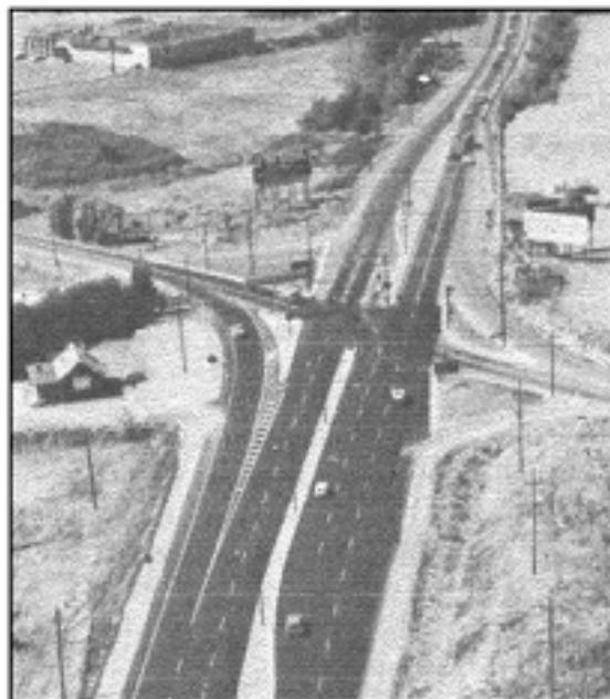
(b) Solução canalizada
