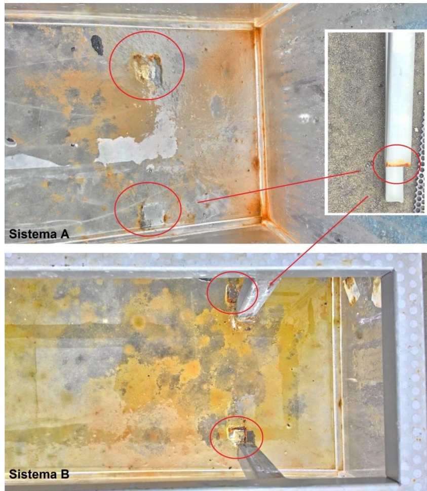
Figura 4.10 – Coloração no fundo da caixa dos sistemas antes da lavagem dos agregados e pé metálico do suporte enferrujado
