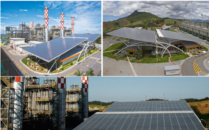
Figura 3.11 - SFVCR MAC 1: sistema integrado às instalações da UTE Norte Fluminense.
