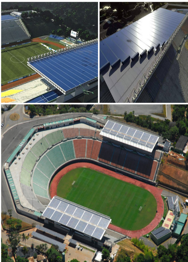
Figura 3.8 - SFVCR SAL-1: sistema integrado ao estádio Pituáçu, em Salvador - BA.
