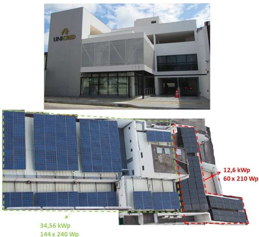
Figura 3.13 - SFVCR BEL-1: sistema BAPV em uma edificação comercial, destacado em vermelho o sistema considerado neste estudo e em verde a ampliação.
