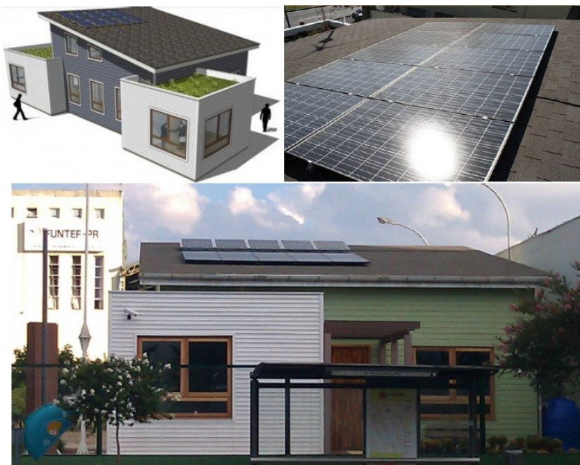
Figura 3.12 - SFVCR CUR-1: sistema integrado à edificação do projeto Escritório Verde da UTFPR.
