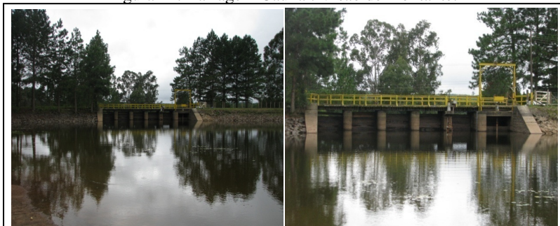
Figura 14. Barragem Caunal. Visão de montante.
