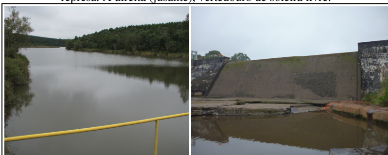
Figura 13. Barragem Salto Grande. À esquerda (montante), lago formado pela represa. À direita (jusante), vertedouro de soleira livre.
