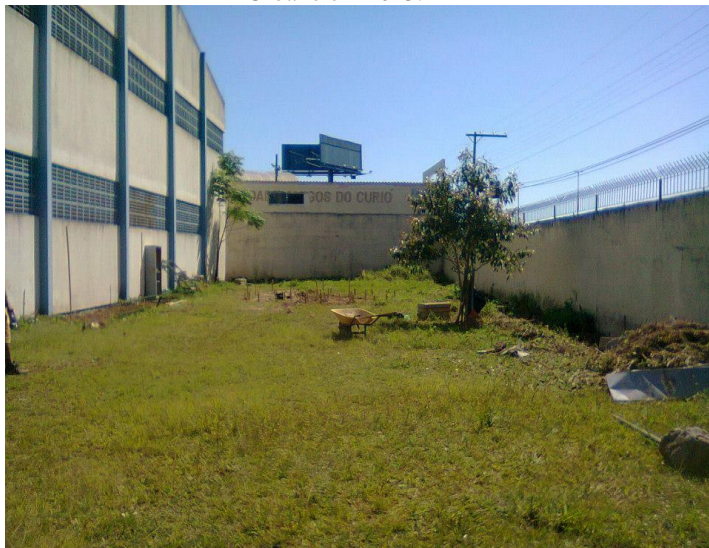
Figura 1- Espaço do canteiro no início do projeto Espaço Coletivo Bicho Urbano em 2013.
