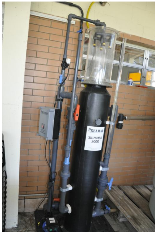
ANEXO C – Foto do “skimmer” (PREAMAR®), modelo 300R e do filtro de disco (AGROJET®) que compõe o sistema. (Fonte: LMM)
