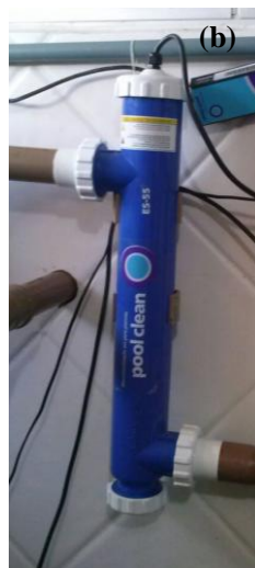
ANEXO E – (a) Bomba de calor (NAUTILUS®) modelo AA-45 e (b) filtro UV (POOL CLEAN®), modelo ES-55. (Fonte: LMM).
