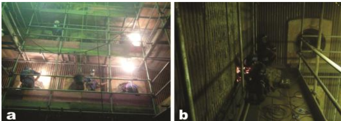
Figura 1.2. Em (a) e (b) operação de inspeção e limpeza de tubos
