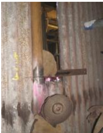
Figura 1.3. Instalação de tubos novos
