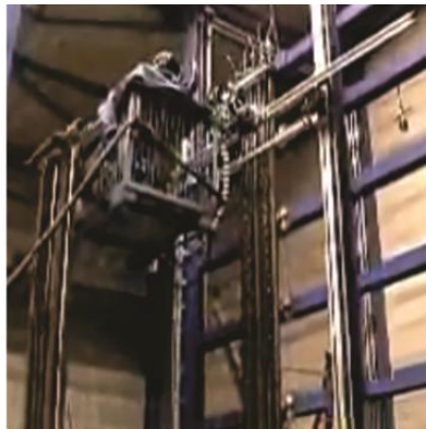
Figura 2.5. Manipulador utilizado para o revestimento de painel tubular em oficina [32]
