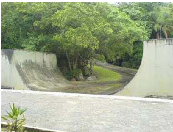
Imagem 18: halfpipe da pista do Jurerê.
