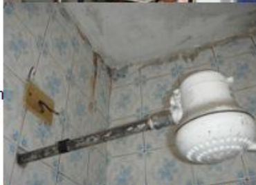
Roupa com etiqueta da marca, falta de espaço, riscos e banho frio (Fotos: FF, BP e SRTE/SP)
