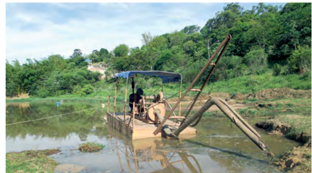
Camada de solo acima do nível de água, chegando a atingir mais de 0,8 metros acima da linha de água.
