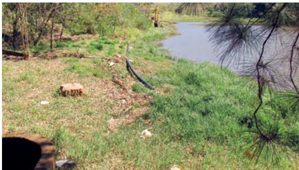
Desembarque da draga na área do represamento. Detalhe do cano que conduzirá a água para as caixas de contenção, através do vertedouro ladrão da represa.
