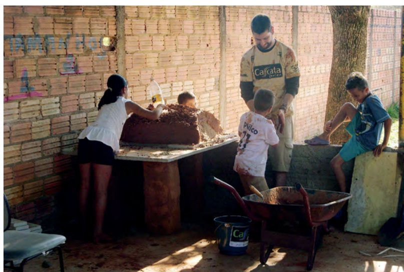
Construção de forno de pizza com a técnica de Cob - construção que utiliza terra arenosa, areia e água. Os blocos de adobe foram utilizados para sustentar a base sobre a qual o forno foi construído.
