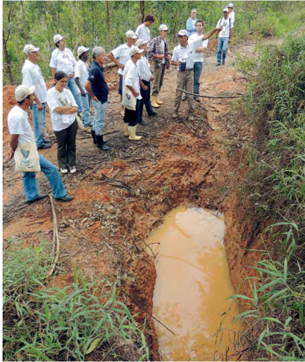
Evento de capacitação na UPEPA Sítio Jaqueira, realizando no mês de Dezembro de 2013. Com destaque para caixa seca implantada no entorno de estrada.
