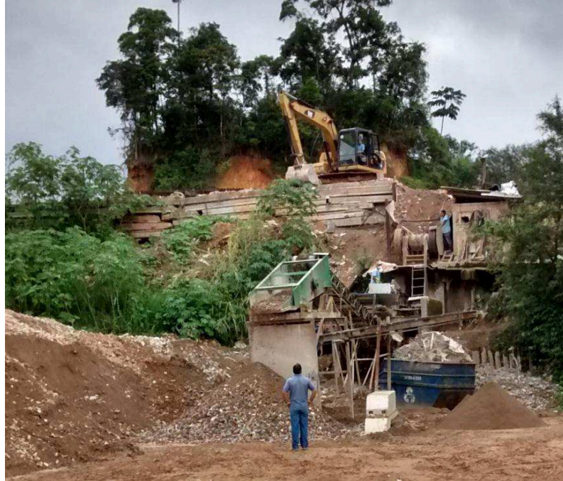
Figura 3.46 – Reciclagem de materiais provenientes de resíduos da construção civil – Empresa A.
