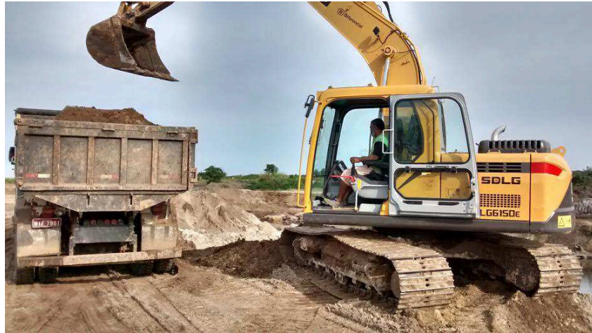
Figura 3.42 – Escavadeira extraíndo areia e carregando o caminhão basculante – Jazida B.
