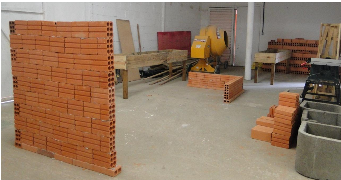
Figura 10: Confeção de estruturas de alvenaria
