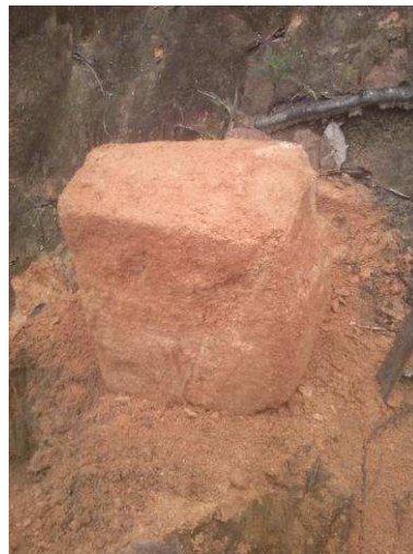
Figura 22 - Tombamento do bloco de solo sobre colchão de solo fofo
