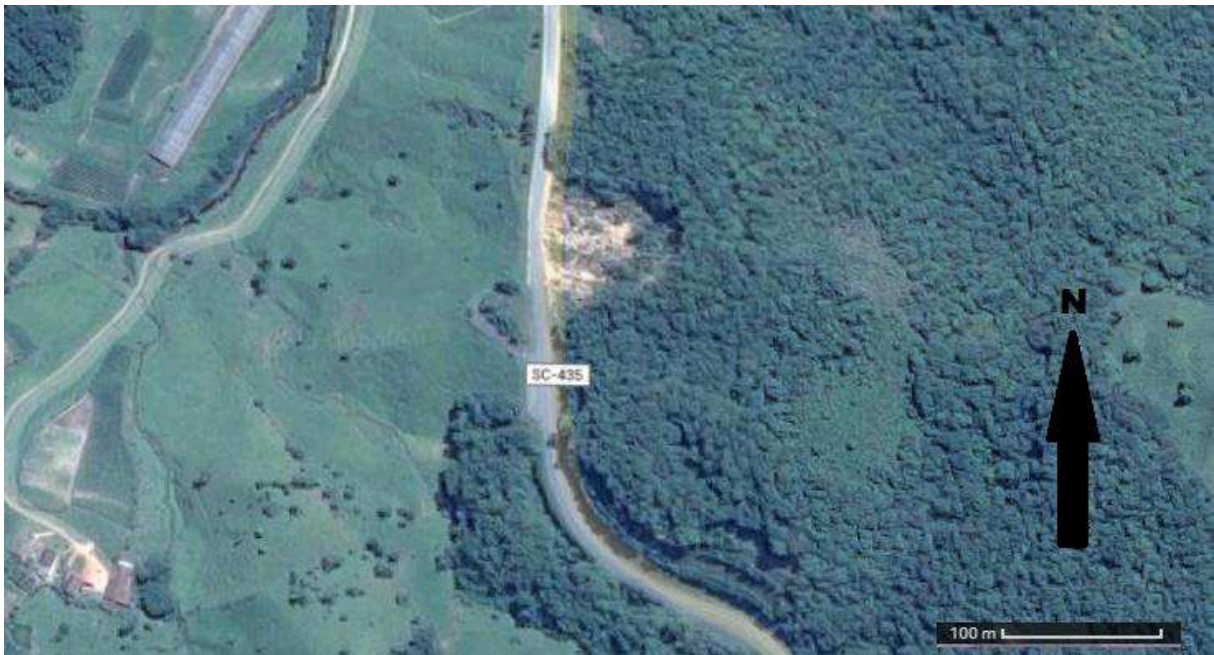
Figura 1 - Deslizamento do talude de corte no km 13,8
