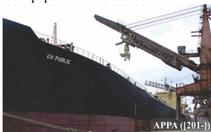
Carregador de navios Porto de Paranaguá (Paranaguá-PR)
