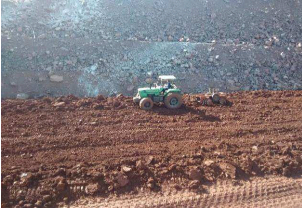
Figura 3.12 – Tratamento da argila no núcleo da barragem
