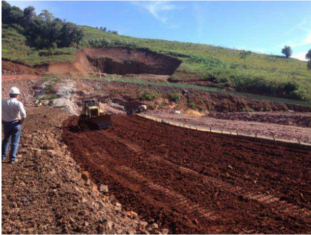
Figura 3.11 – Espalhamento da camada de argila na barragem
