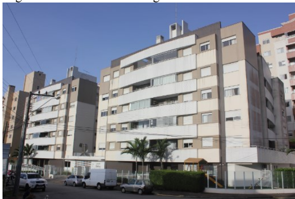
Figura 30 Condomínio Córrego Grande – Fachada Noroeste
