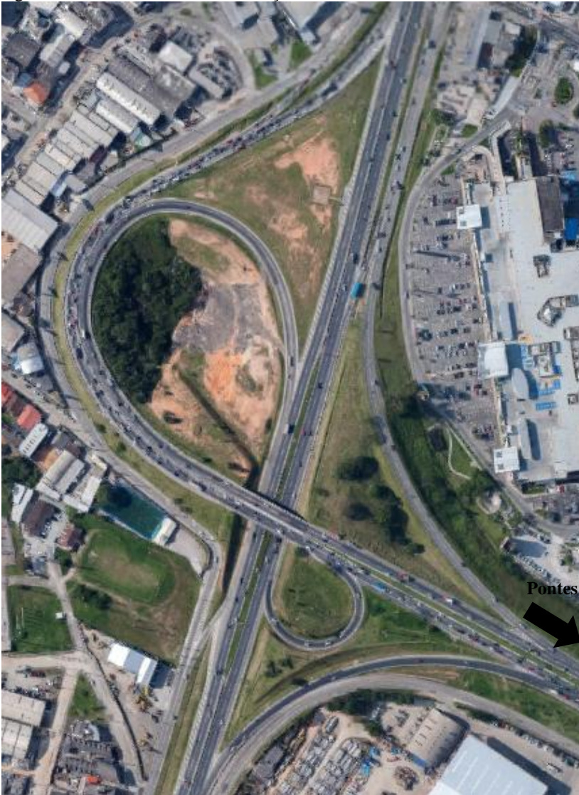
Figura 28 – Rodovia BR-101, condição atual.
