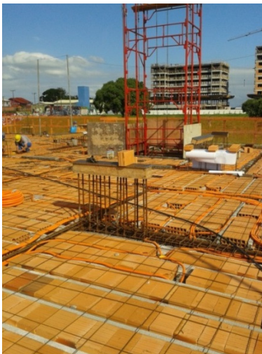
Figura 29 – Laje pré-moldada executada pela MOT
