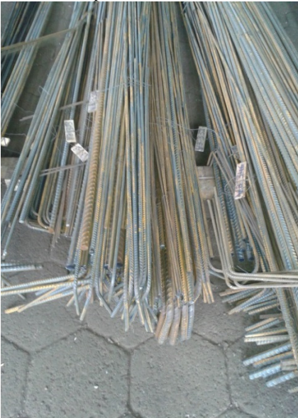
Figura 6 – Estoque de barras longitudinais de aço pré-cortadas e pré-dobradas
