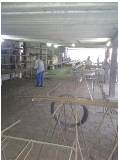
Figura 24 – Central de armação
