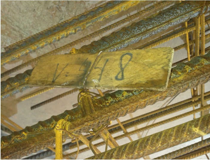
Figura 27 – Placa de identificação dos elementos estruturais
