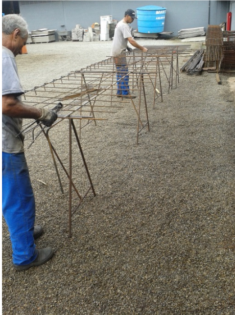
Figura 16 – Início do serviço de montagem
