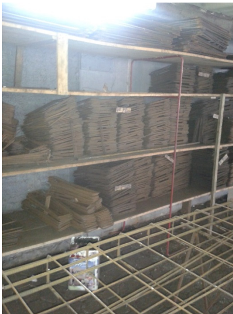
Figura 26 – Estoque de estribos a serem utilizados pela mão de obra própria
