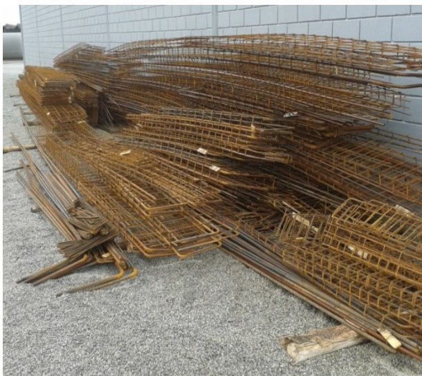
Figura 8 – Estoque de vigas pré-montadas
