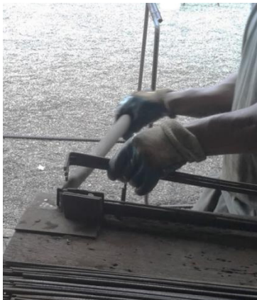
Figura 14 – Dobragem utilizando bancada com pinos e chave de dobra
