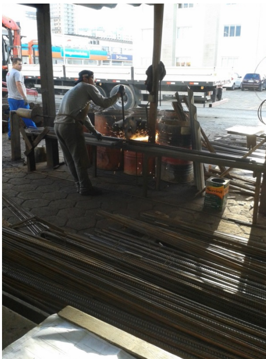
Figura 11 – Execução do serviço de corte de barras de aço
