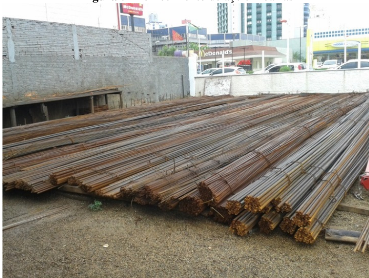
Figura 5 – Fornecimento de aço em barras
