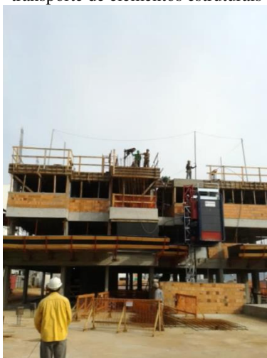
Figura 30 – Guincho motorizado para transporte de elementos estruturais
