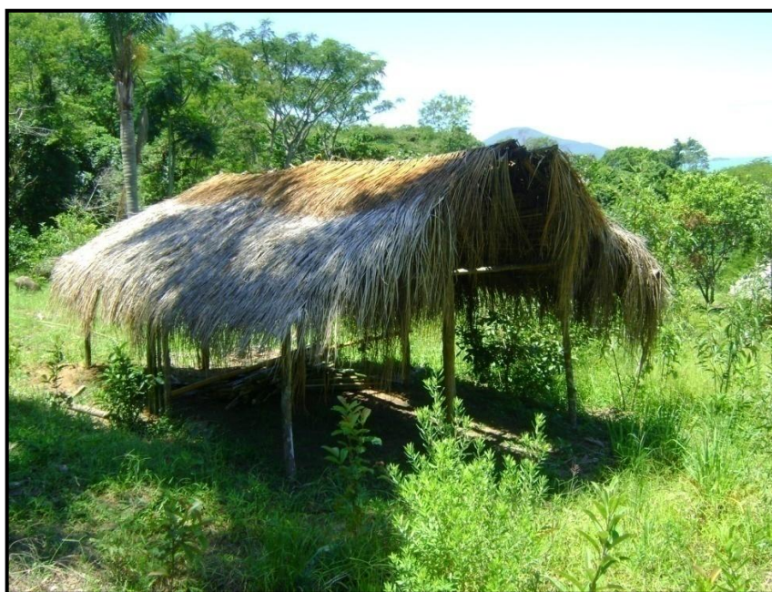
Figura 13 – Foto da “minha” casa, com telhado de pindo hogue , em construção. Foto do autor.
