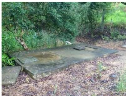
**Figura 7 - Tanque séptico enterrado.**
