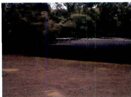
Figura 21: Balão de biogás Fonte: Arquivo do autor
