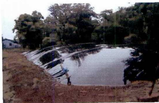
Figura 16: Biodigestor da Granja Suruvi Fonte: Arquivo do autor
