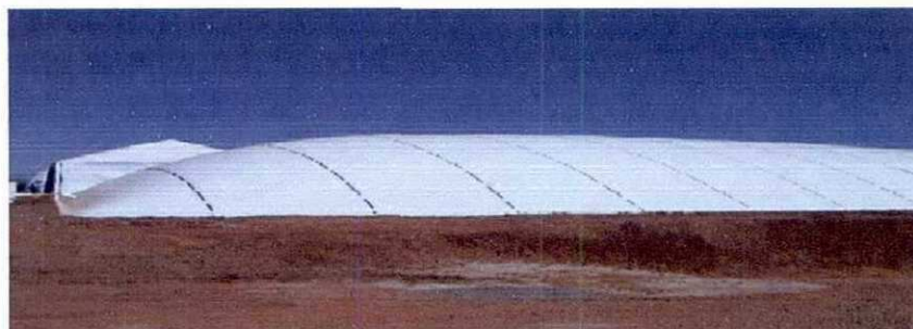
Figura 5: Biodigestor modelo Marinha ou Canadense Fonte: Arquivo pessoal do autor
