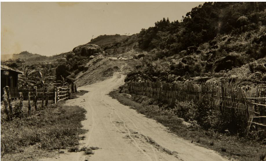
Estrada Geral de Jurerê Tradicional sendo aberta em 1957
