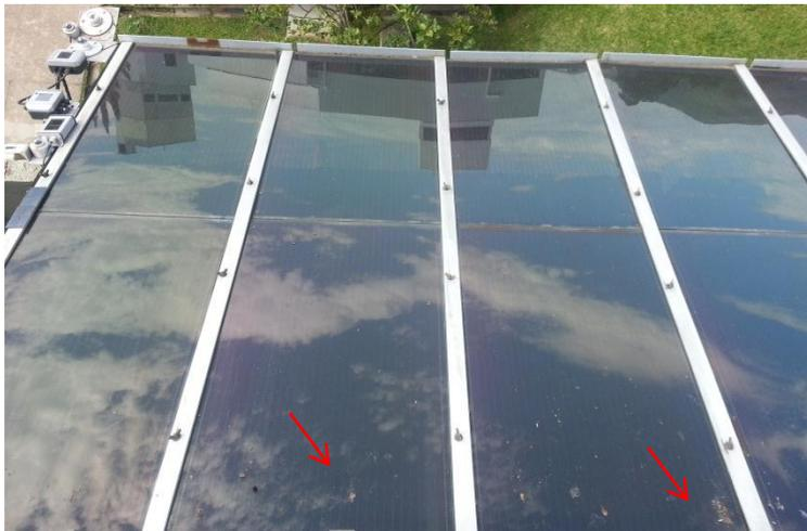
**Figura 47. Módulos FV do 2kWp, em detalhe pontos de sujeira ocasionados por pássaros.**
