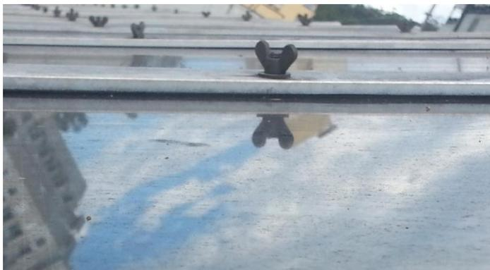
**Figura 48. Distribuição uniforme de sujeira sobre o gerador FV.**
