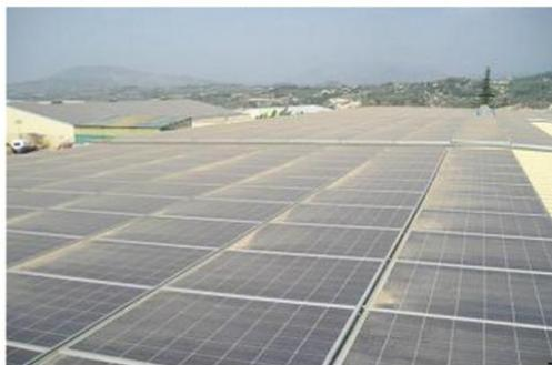
**Figura 12. Não uniformidade de sujeira em um sistema FV (LORENZO *ET AL.*, 2013)**
