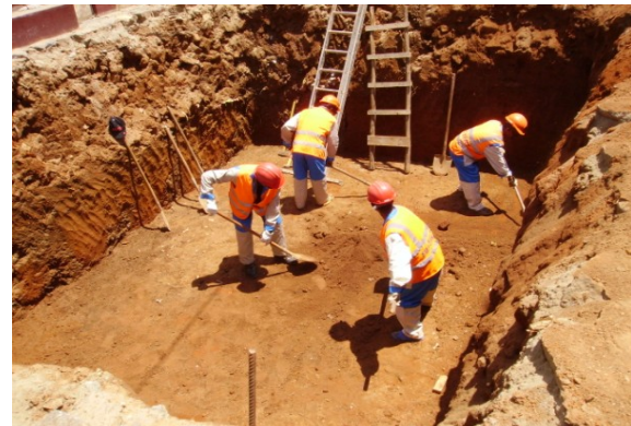
Terrassement : réglage fond de fouille
