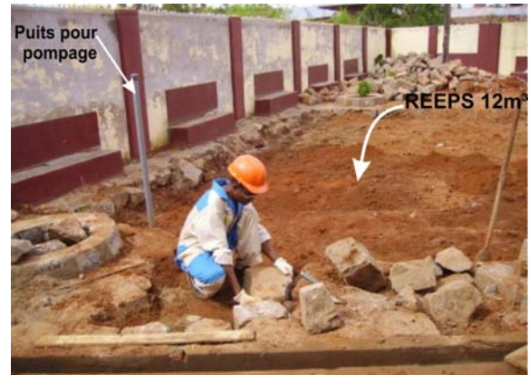
Remblaiement fini
