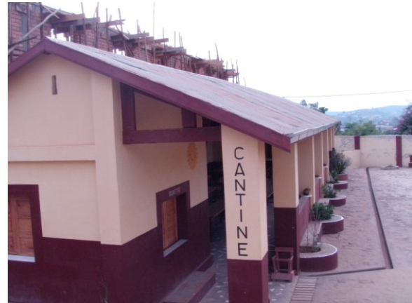
Toiture d'approvisionnement du REEPS
