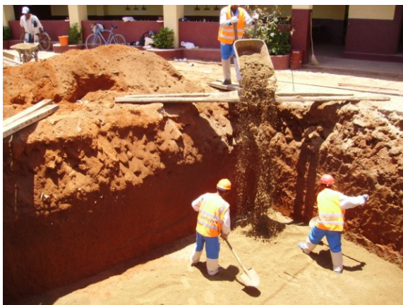
Réalisation lit de sable
