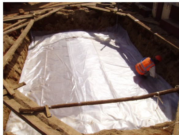
Pose du toit
