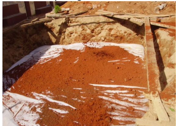
Remblaiement REEPS
