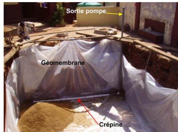
Pose géomembrane et crépine
