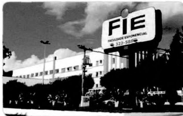
Figura 2: Prédio da Faculdade Exponencial
