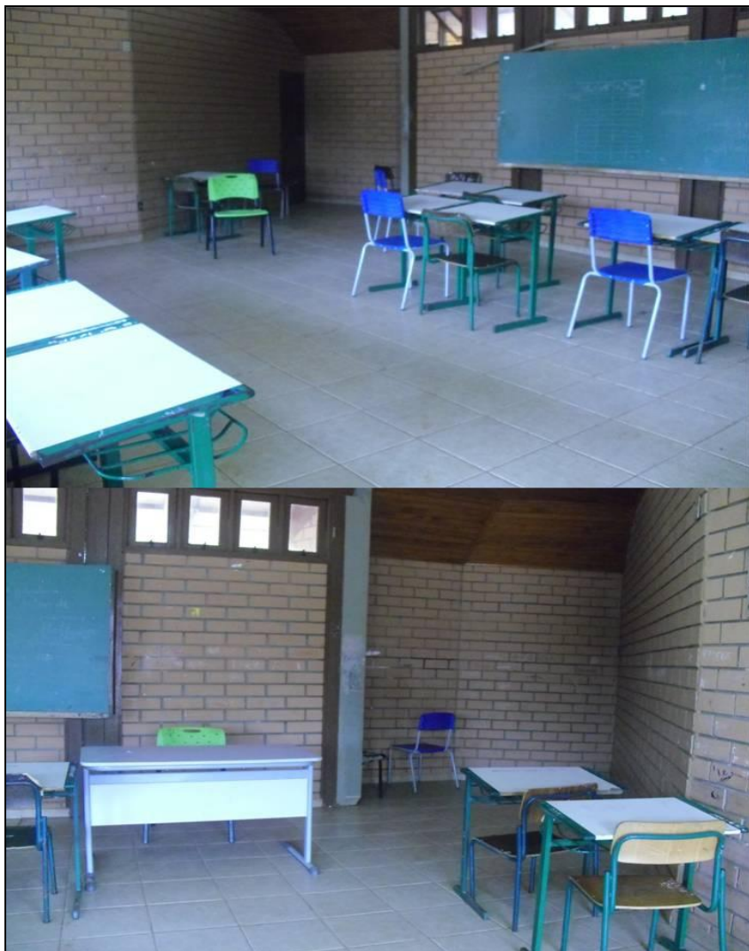
Figura 27: Antiga sala de “chão batido” que era utilizada exclusivamente para as aulas de Artes, na EIEB Cacique Vanhkrê.
