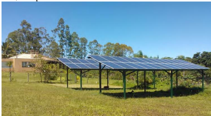
Figura 64 – Gerador fotovoltaico de 11,04 kWp instalado em residência particular, Campo Grande.
