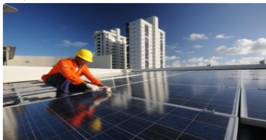
Figura 68 – Gerador fotovoltaico de 44,0 kWp instalado no prédio da reitoria do IFRN, Natal.
