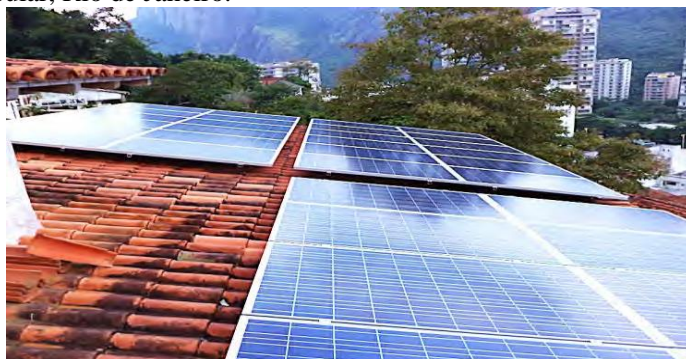
Figura 66 – Gerador fotovoltaico de 8,0 kWp instalado em residência particular, Rio de Janeiro.
