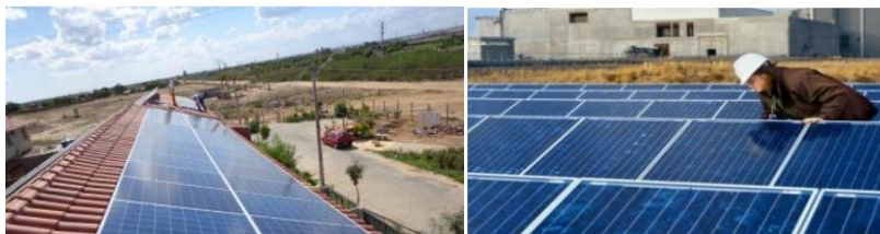
Figura 67 – Gerador fotovoltaico de 2,103 MWp instalado em condomínios residenciais, Juazeiro.
