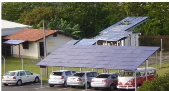
Figura 58 – Gerador fotovoltaico de 3,0 kWp instalado em IEE/USP, São Paulo.
