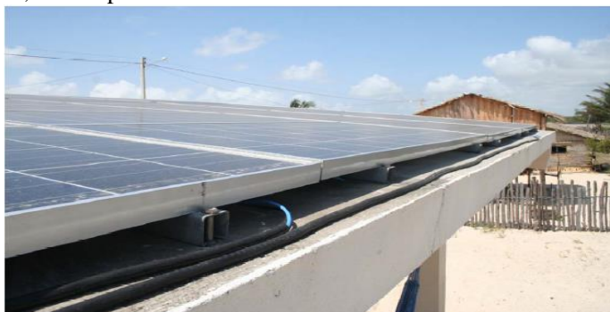
Figura 65 – Gerador fotovoltaico de 21,06 kWp instalado na Ilha dos Lençóis, Cururupu.
