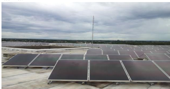
Figura 59 – Gerador fotovoltaico de 50,0 kWp instalado na embaixada italiana, Brasília.
