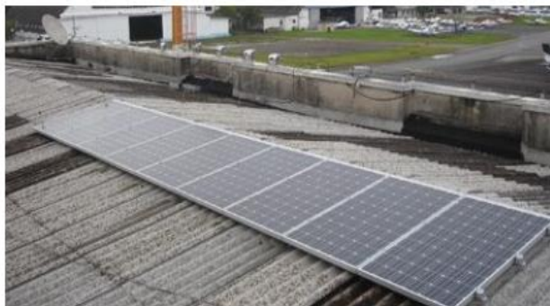
Figura 61 – Gerador fotovoltaico de 2,12 kWp instalado no Aeroporto Campo de Marte, São Paulo.
