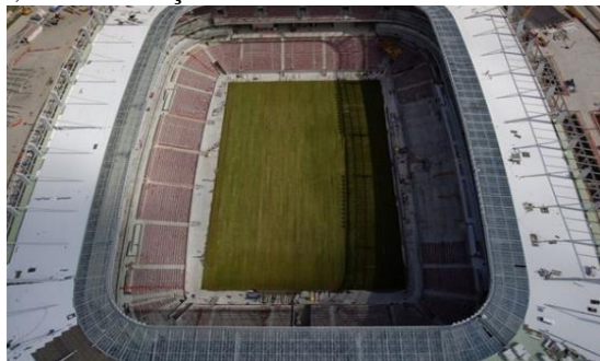
Figura 70 – Gerador fotovoltaico de 967,0 kWp instalado na Arena Pernambuco, São Lourenço da Mata.
