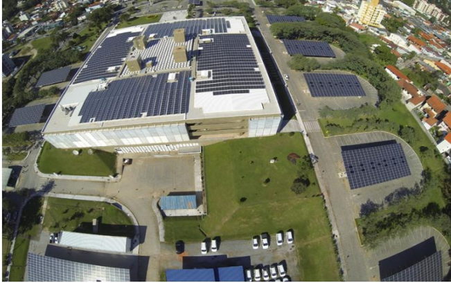
Figura 18 – Vista aérea do sistema fotovoltaico de 1 MWp - Megawatt Solar.
