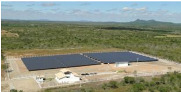
Figura 56 – Gerador fotovoltaico de 1,0 MWp instalado em Tauá, Ceará.
