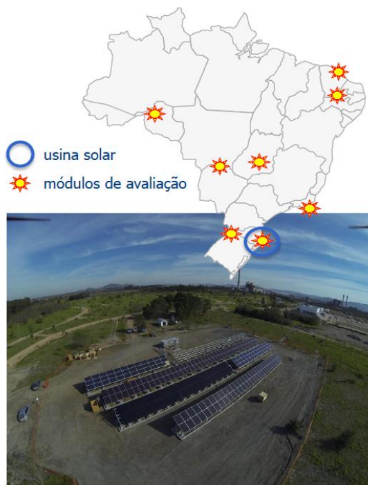
Figura 73 – Localização dos módulos de avaliação instalado e módulo de avaliação instalado em Capivari de Baixo/SC.
