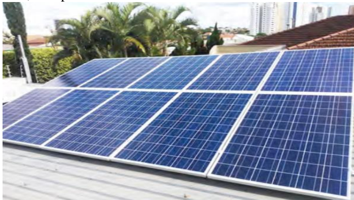
Figura 63 – Gerador fotovoltaico de 2,3 kWp instalado em residência particular, Campo Grande.
