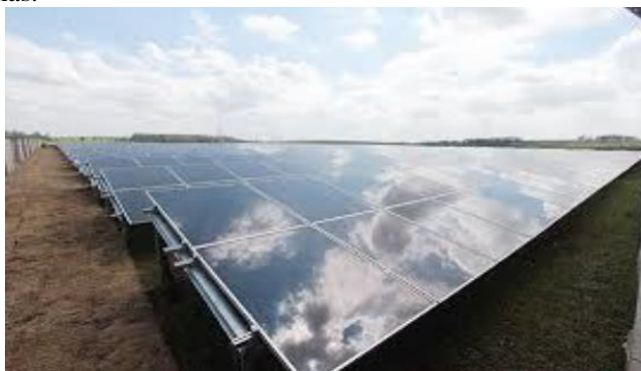
Figura 62 – Gerador fotovoltaico de 1,082 MWp instalado em Campinas.
