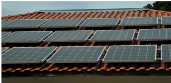
Figura 69 – Gerador fotovoltaico de 8,64 kWp instalado na empresa Elco Engenharia, Curitiba.
