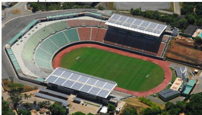
Figura 60 – Gerador fotovoltaico de 404,8 kWp instalado no Estádio Estadual de Pituáçu, Salvador.
