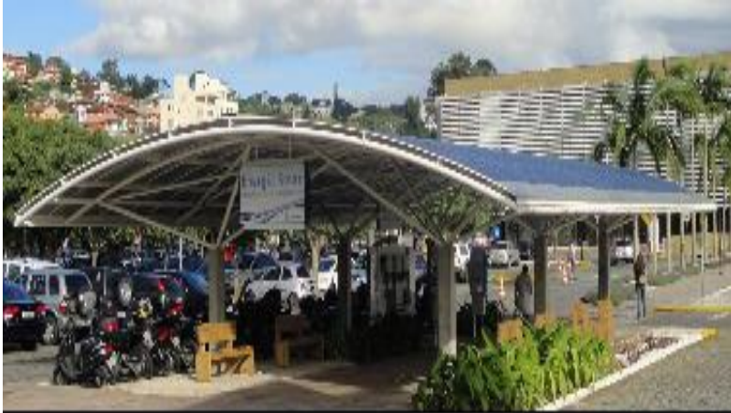
Figura 24 – Gerador de 12 kWp – Planta piloto da Eletrosul.
