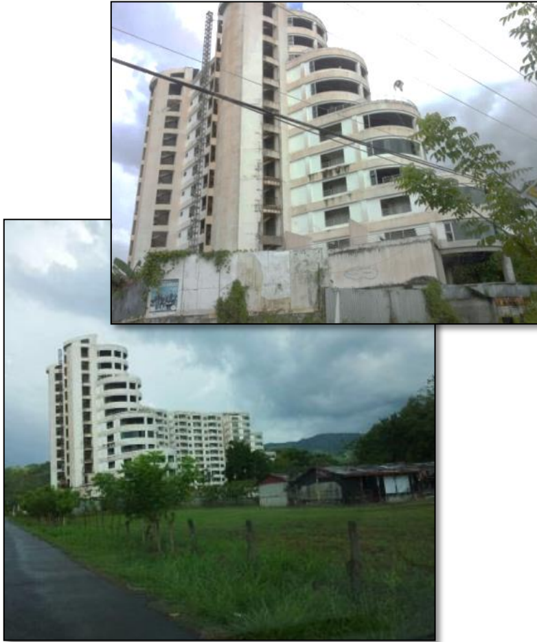
Foto 33 - Prédios abandonados na praia Jacó , no litoral Pacífico da Costa Rica, devido à recessão de 2008
