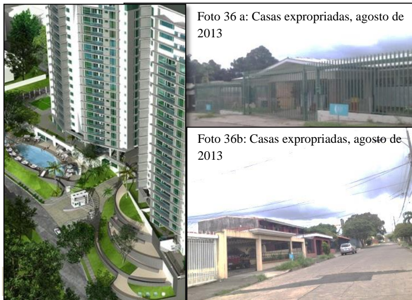
Foto 36 - Casas a serem demolidas para realizar a construção do projeto Duo Luxury Condos
