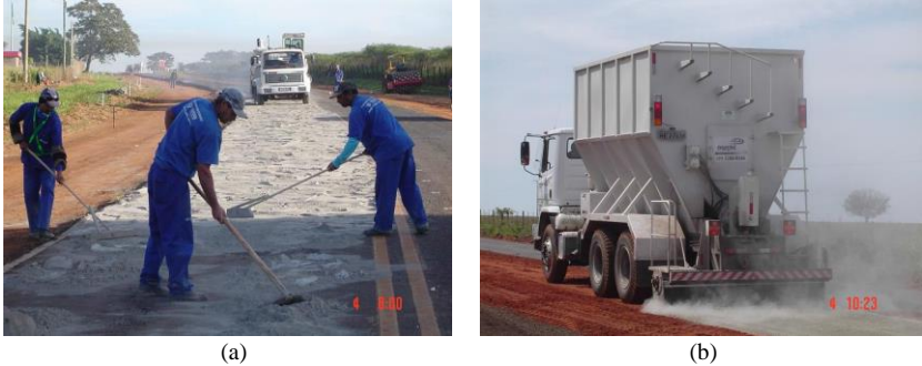
Figura 13: Espalhamento do agente estabilizador (a) sacos; (b) caminhão
