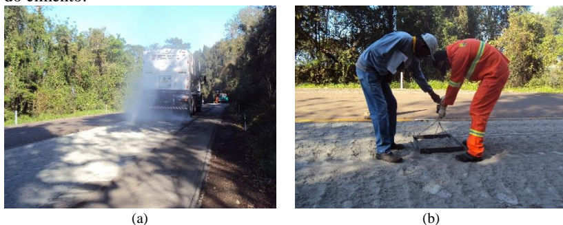
Figura 46: (a) Espalhamento do cimento, (b) Verificação da taxa de aplicação do cimento.
