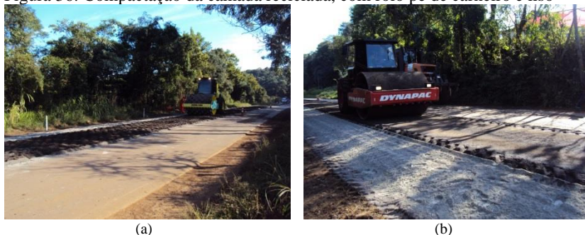
Figura 36: Compactação da camada reciclada, com rolo pé de carneiro e liso
