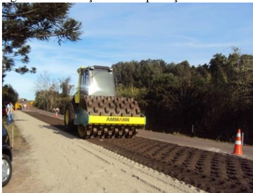
Figura 42: Execução da compactação da camada reciclada
