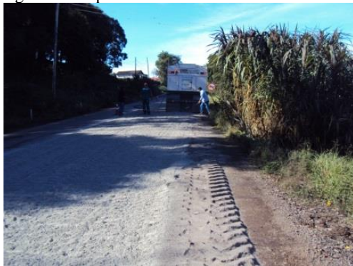
Figura 34: Espalhamento do cimento
