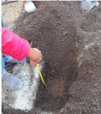
Figura 47: Verificação da espessura de corte reciclado.
