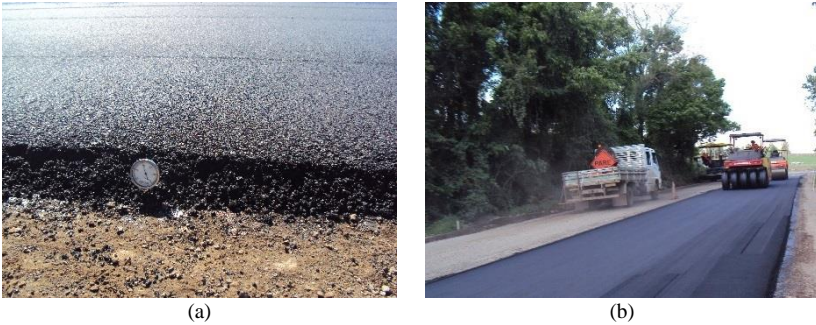
Figura 56: (a) verificação da temperatura de rolamento, (b) compactação do revestimento
