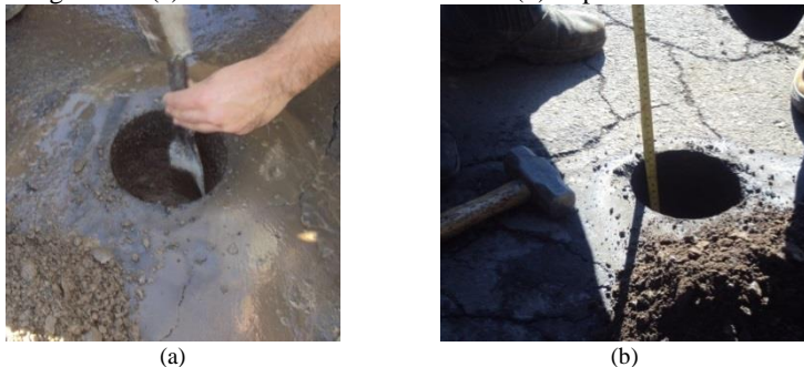
Figura 26: (a) Retirada do material da base (b) Espessura base
