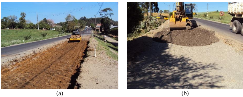
Figura 54: (a) Compactação do subleito (b) Compactação da nova camada de base
