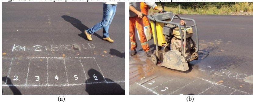
Figura 58: Extração placas para ensaio de deformação permanente.
