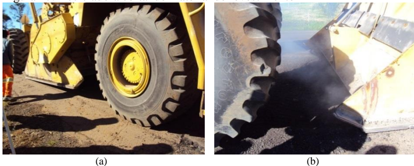
Figura 27: Recicladora cortando material de revestimento
