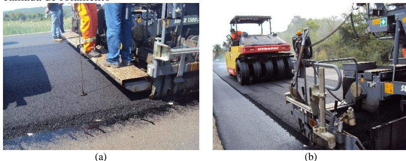
Figura 57: (a) verificação da espessura de lançamento (b) compactação da camada de rolamento
