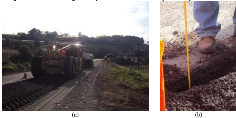
Figura 40: (a) Reciclagem do pavimento (b) verificação da espessura reciclada
