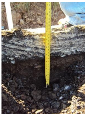
Figura 31: Espessura da camada reciclada
