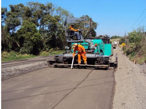
Figura 38: Espelhamento e nivelamento do pó de pedra.
