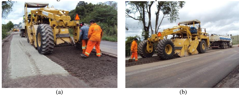
Figura 55: Reciclagem dos remendos com nova adição de cimento
