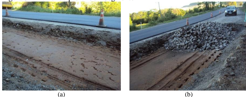
Figura 52: Remendo profundo - Segmento 2
