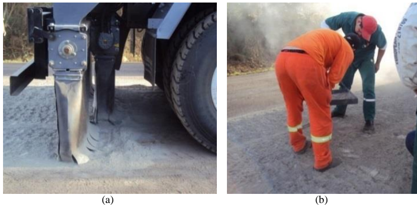
Figura 39: (a) Espalhamento do cimento, (b) Controle da taxa de aplicação cimento
