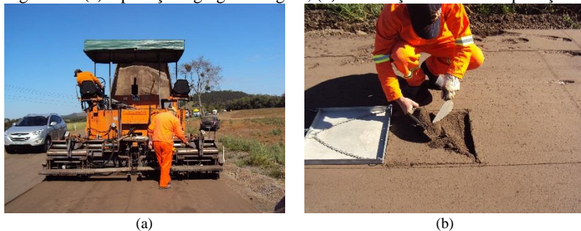
Figura 45: (a) Aplicação agregado virgem, (b) verificação da taxa de aplicação
