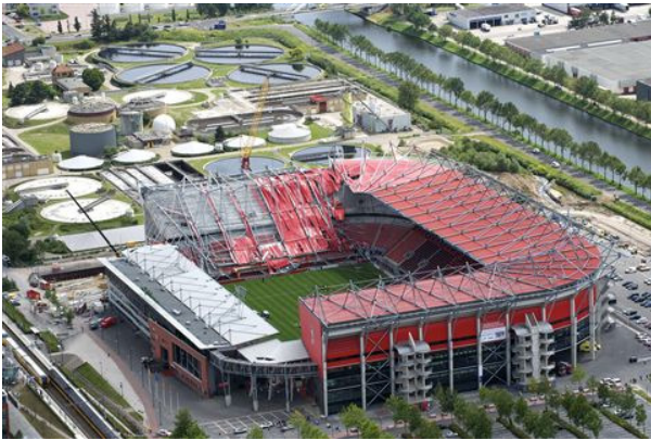
Figura 38 – Queda de estrutura em estádio na Holanda
