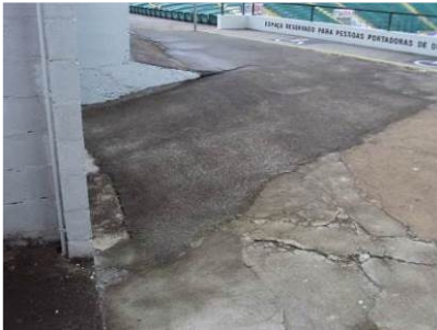
Figura 70 – Rampa interna Setor B1
