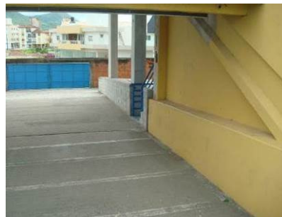
Figura 73 – Rampa externa Setor C
