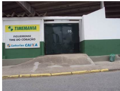
Figura 71 – Rampa externa Setor C
