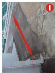
Foto 2 - Rampa do Setor B1
