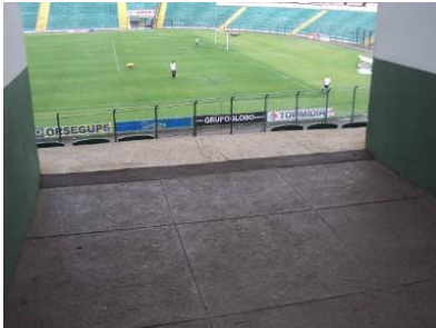
Figura 58 – Desnível na saída
