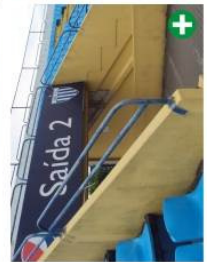
Foto 2 - Rampa da saída 2. Falta corrimão
