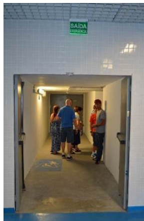
Figura 109 – Porta Corta fogo Figura 110 – Corredor enclausurado
