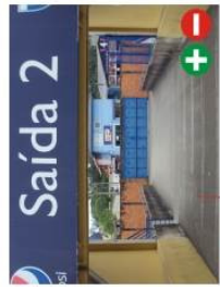
Foto 2 - Rampa da saída 2. Falta corrimão
