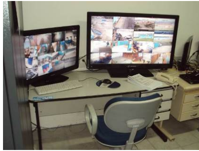
Figura 77 – Sala de monitoramento 2
