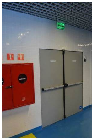
Figura 109 – Porta Corta fogo Figura 110 – Corredor enclausurado
