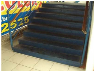
Figura 62 – Escada interna (Ressacada)
