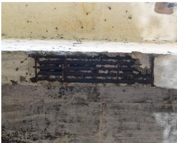
Figura 29 - Armadura exposta com presença de nicho de concretagem e corrosão.
