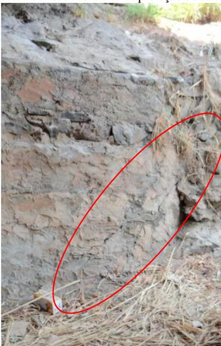
Figura 34 - Fissura do lado jusante da proteção do talude do lado sul
