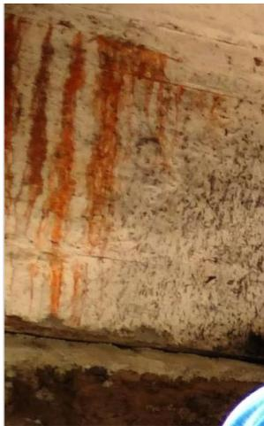
Figura 31 - Infiltração de água na transversina.
