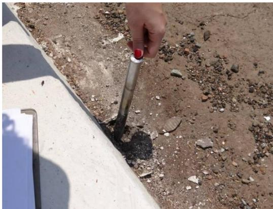
Figura 35 - Drenagem - Tubulação entupida
