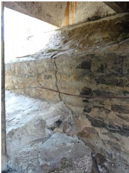
Figura 33 - Fissura do lado montante da proteção do talude do lado sul
