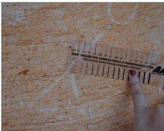
Figura 28 - Fissura na longarina sobre pilar
