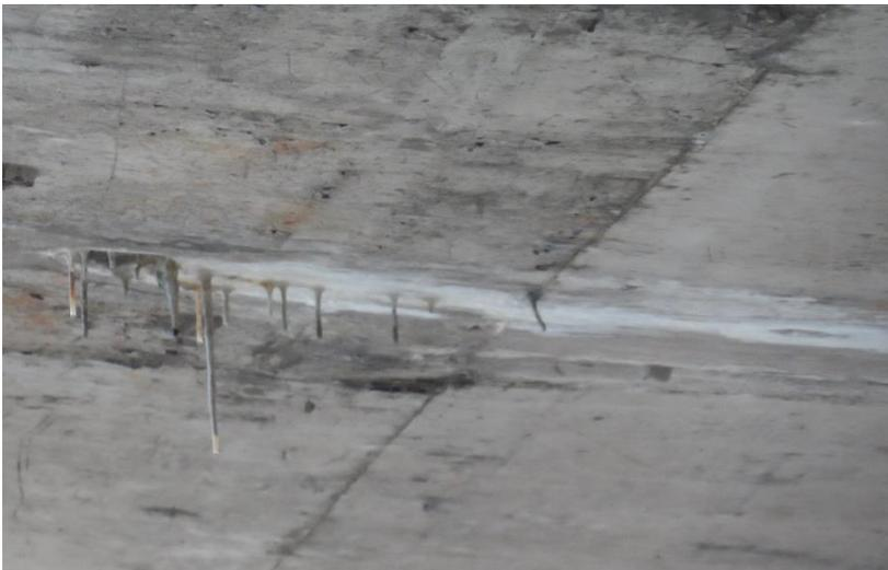
Figura 5 – Carbonatação por lixiviação
