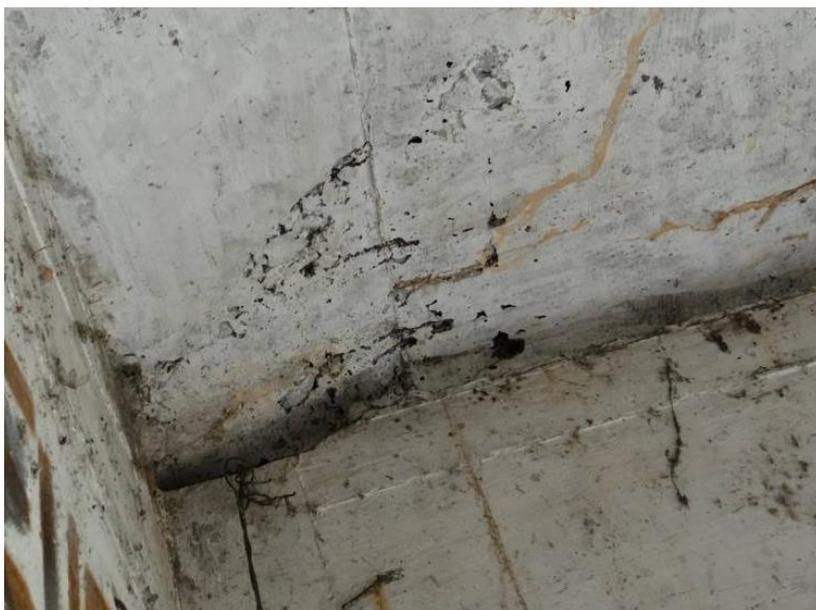
Figura 25 - Nicho de concretagem na laje
