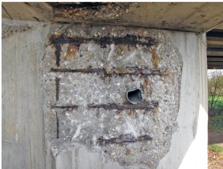
Figura 6 – Desagregação do concreto devido à corrosão das armaduras
