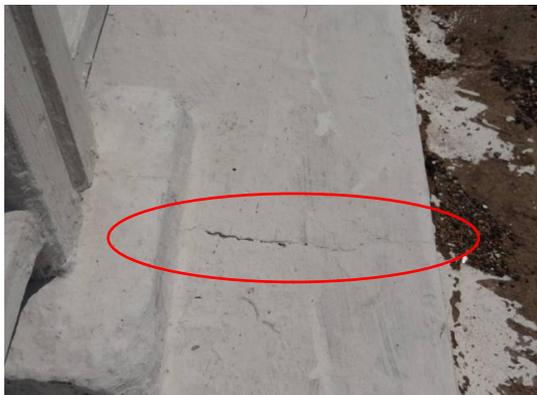
Figura 40 - Fissura no guarda roda
