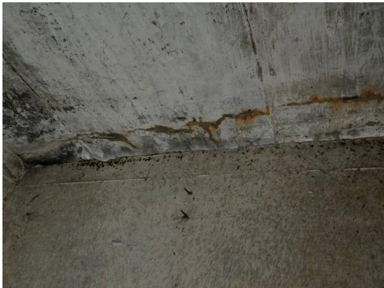
Figura 26 - Fissura com infiltração de água na laje
