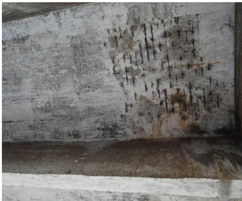
Figura 27 - Umidade e desagregação do concreto na laje
