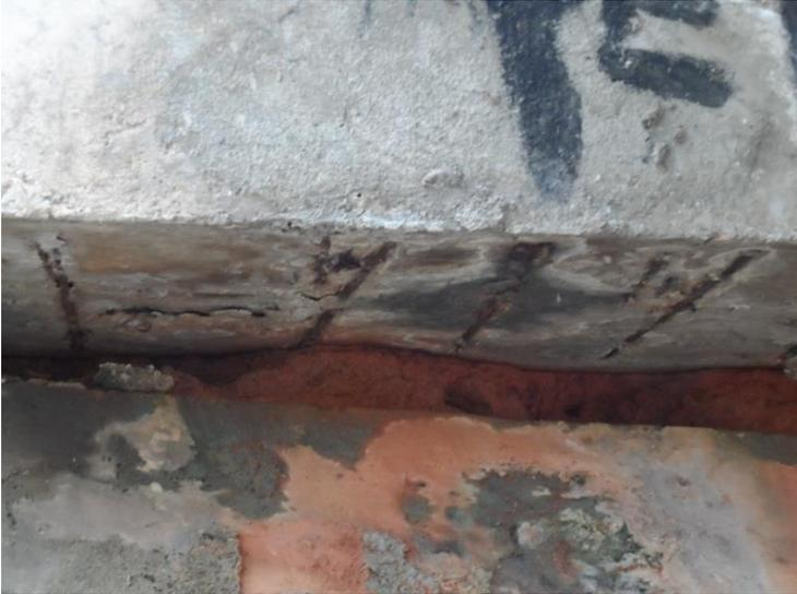
Figura 7 – Corrosão de armadura
