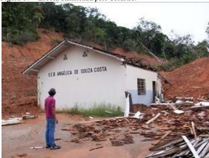
Figura 17 – Escola danificada pelo desastre.
