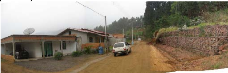
Figura 15 – Rua principal da localidade da Beira Baixa sem pavimentação.
