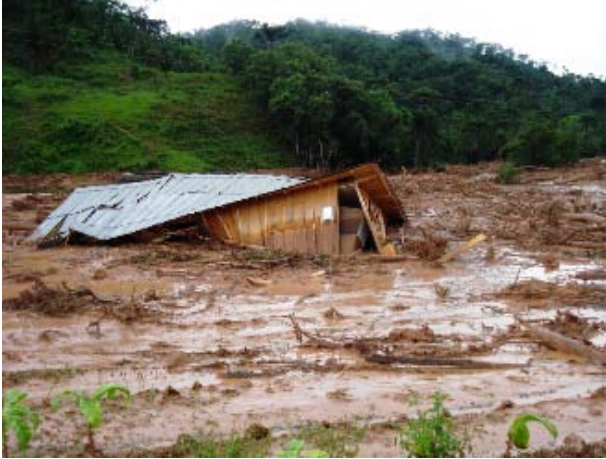
Figura 14 – Casa destruída pela inundação.
