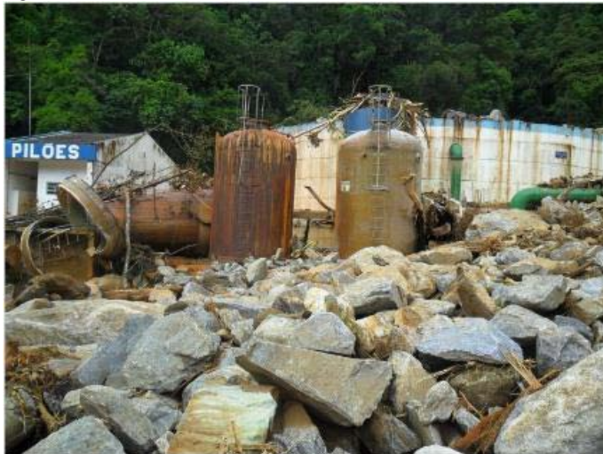
Figura 23 – Sistema de abastecimento danificado devido ao desastre.
