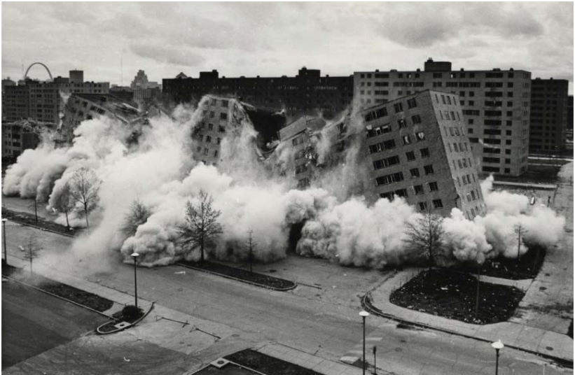
Figura 23: Demolição do Pruitt-Igoe em 1972 -
