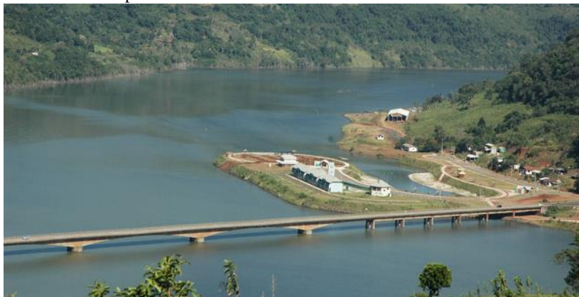
Figura 14 - Fotografia terrestre vista direita da ponte sobre o rio Uruguai pós UHE Foz do Chapecó.
