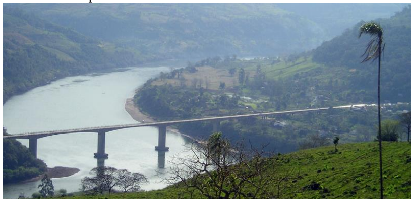
Figura 15 - Fotografia terrestre vista esquerda da ponte sobre o rio Uruguai pré UHE Foz do Chapecó.
