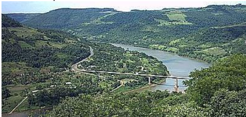
Figura 17 - Fotografia terrestre vista esquerda da ponte sobre o rio Uruguai pré UHE Foz do Chapecó.
